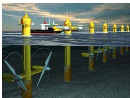
**Figura I.20 Planta de generación de energía con corrientes marinas.
