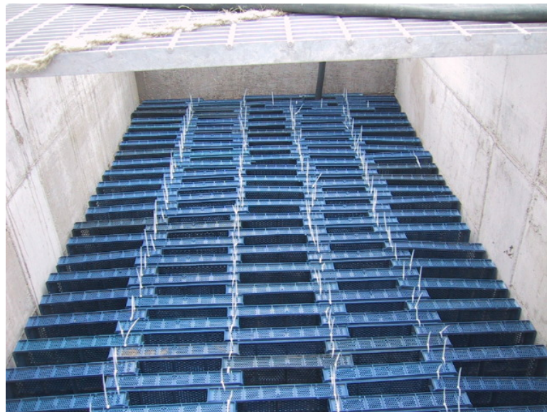
Figura 4.23 Montaje terminado de las cajas.
