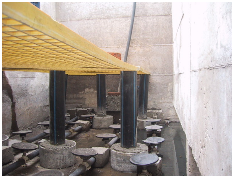
Figura 4.20 Soportes y base de rejilla Irving donde yacerán las cajas.
