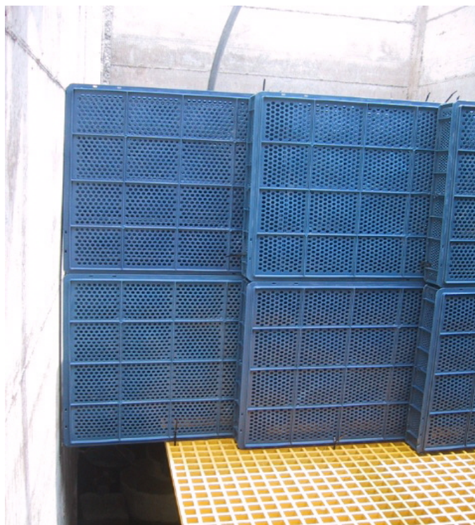
Figura 4.21 Vista frontal de montaje de las cajas sobre la rejilla Irving.
