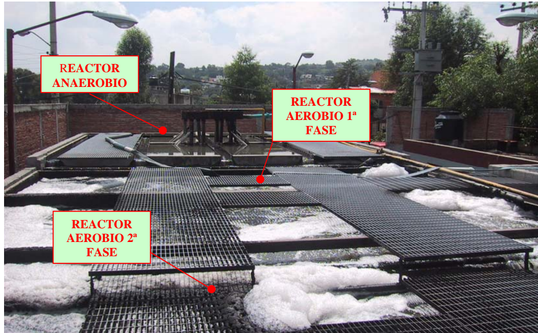
Figura 3.5 Presencia de espumas blancas en los reactores aerobios.
