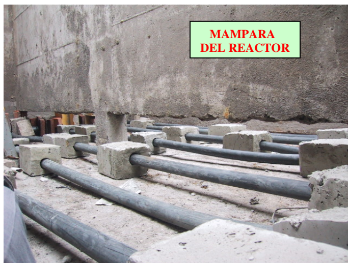
Figura 4.17 Tendido de tubería de polietileno con sus muertos
