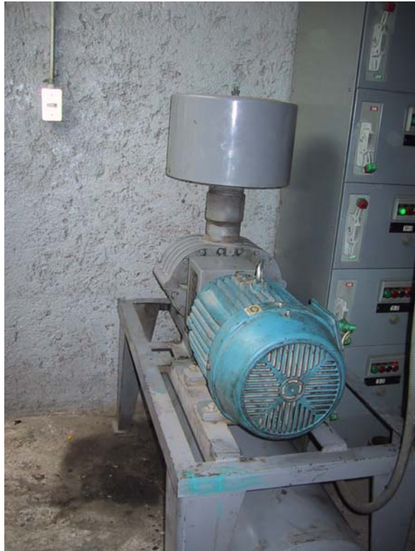
Figura 2.14 Soplador de lóbulo rotativo
