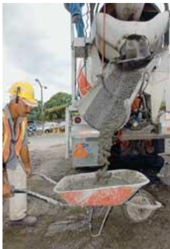
Fig. 2.1 Fabricación de concreto.
