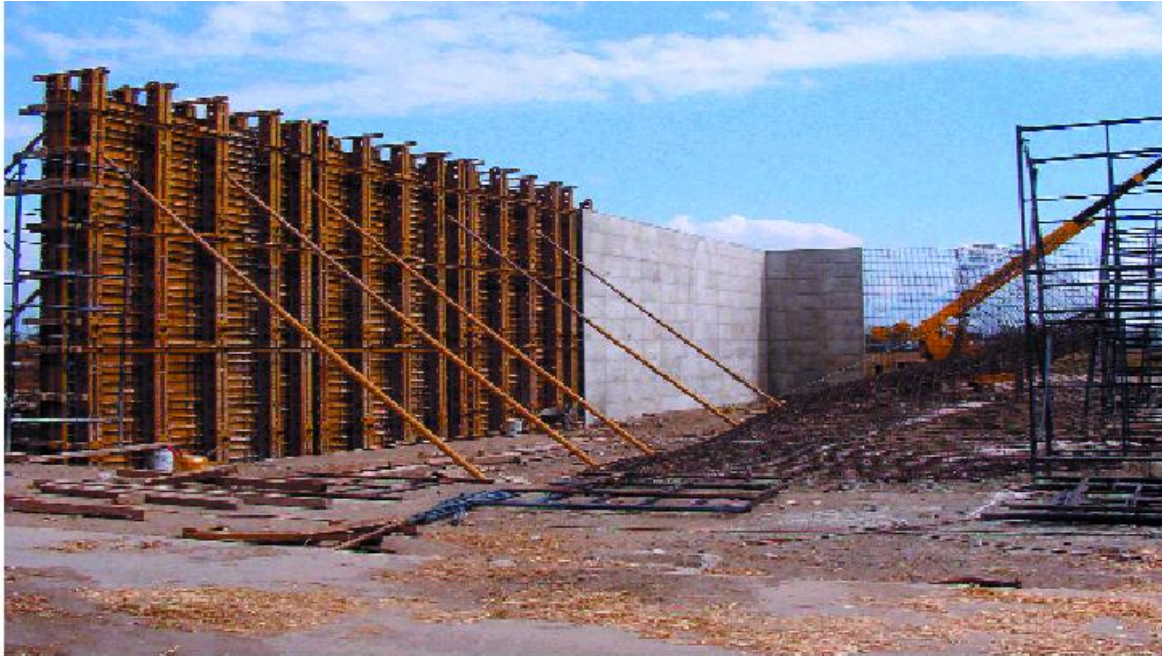
Figura 5. Construcción de almacenes con concreto autocompactable.
