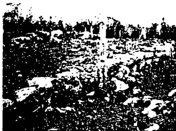
Otra vista del mismo camino maya. Nótese las hileras externas de piedra gruesa confinando el material central más fino.
