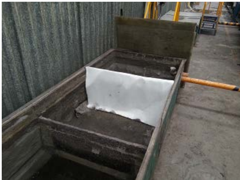
Fig. 5-15 Colocación de tela-filtro en fosa de sedimentación
