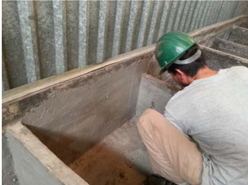
Fig. 5-12 Mantenimiento a paredes de fosa
