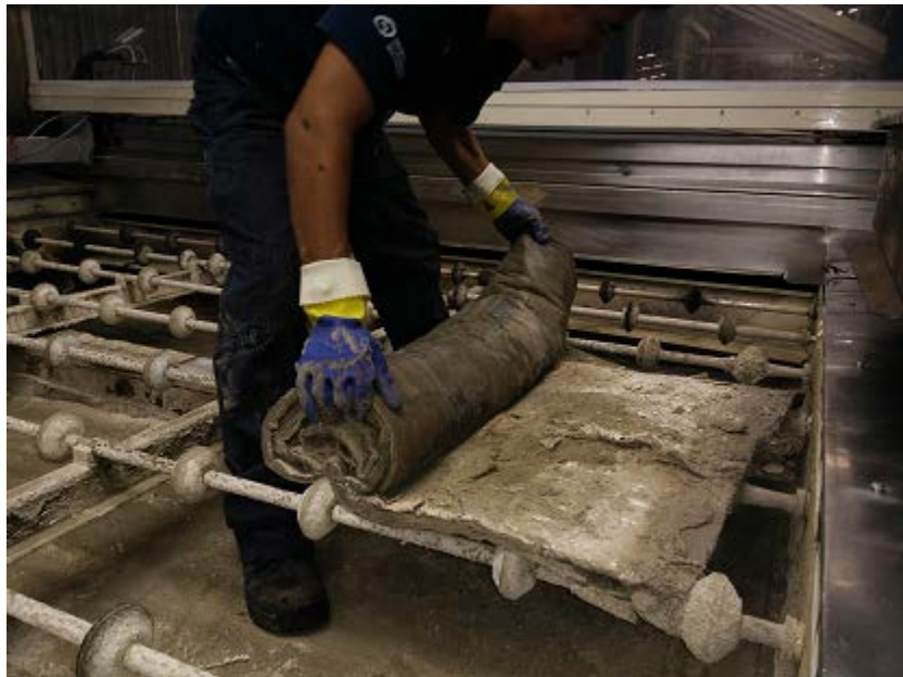
Fig. 5-17 Enrollado de tela impregnada de costras de lodo residual
