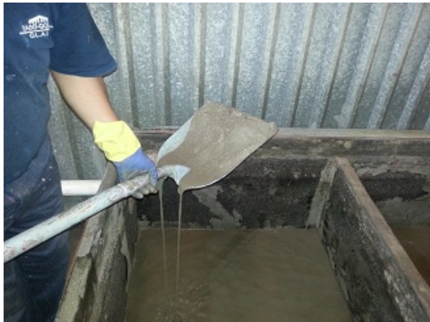
Figs. 5-7 y 5-8 Recuperación de lodo residual en fosas de sedimentación
