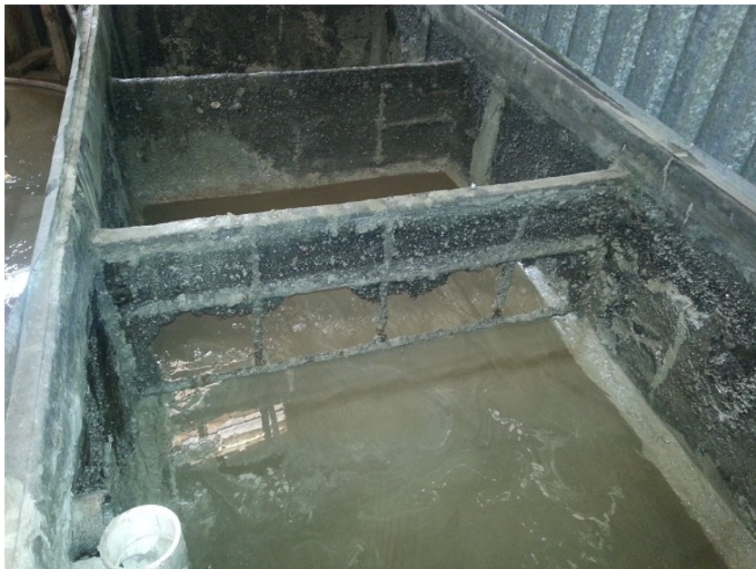
Figs. 5-10 y 5-11 Daño a paredes de fosa de sedimentación
