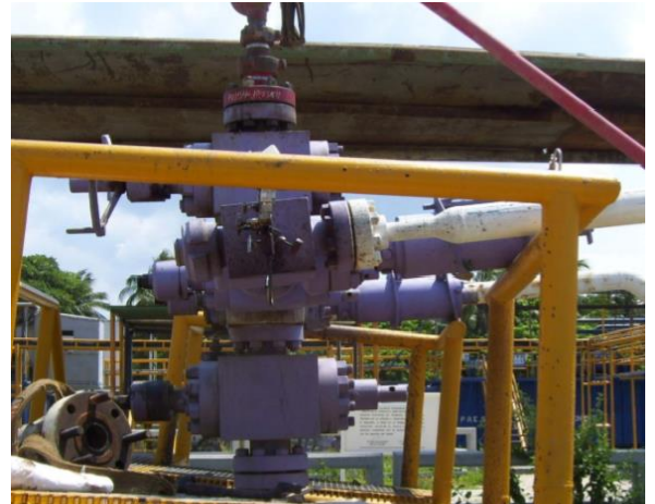
Figura 63 Salidas lateral sostenidas en andamio.
