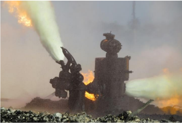
Figura 82 Conexiones superficiales de control del pozo Terra 123, después de remover los escombros del equipo de perforación
