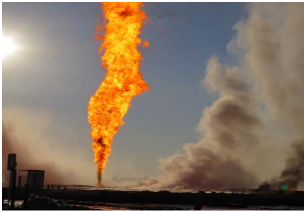
Figura 80 Fuga de hidrocarburos vertical después del corte.
