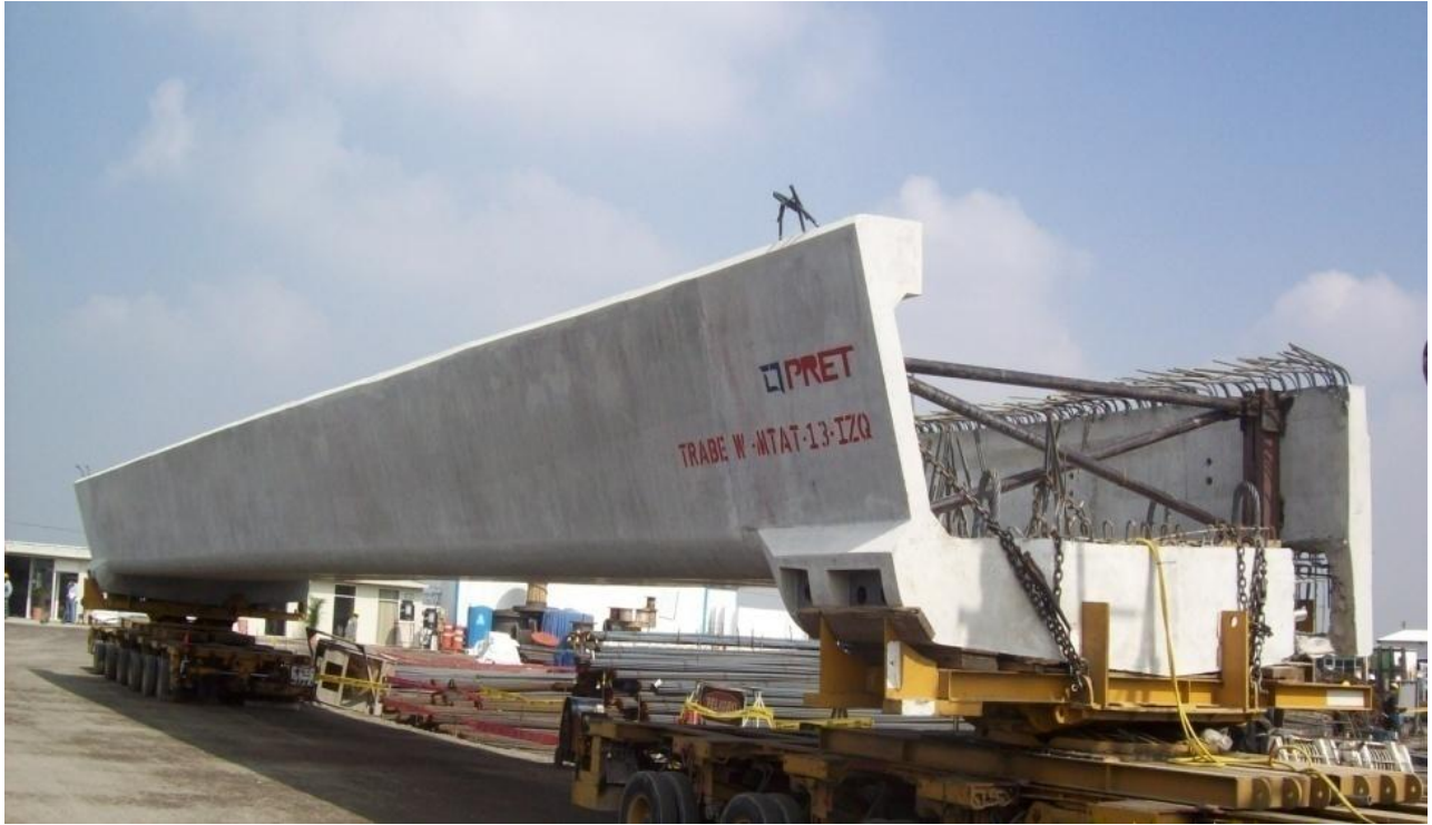
Figura IV.3.18.- Liberación de la trabe para su montaje. (Foto tomada por el autor)
