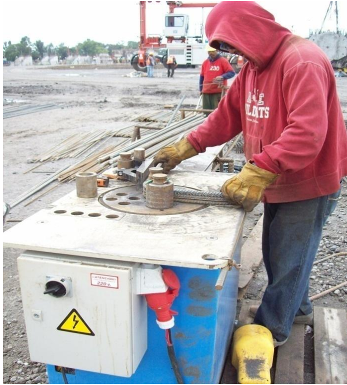
Figura IV.3.4.- Habilitado del acero. (Foto tomada por el autor)
