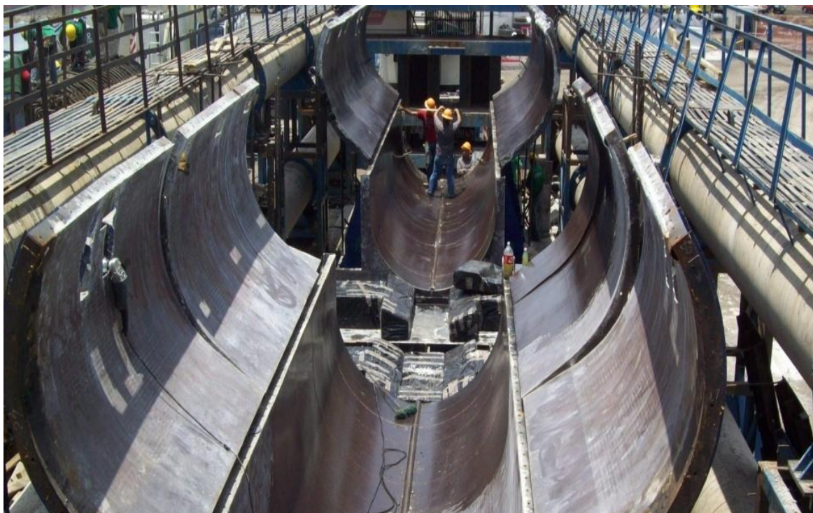
Figura IV.2.1.- Fabricacion del molde (Foto tomada por el autor)
