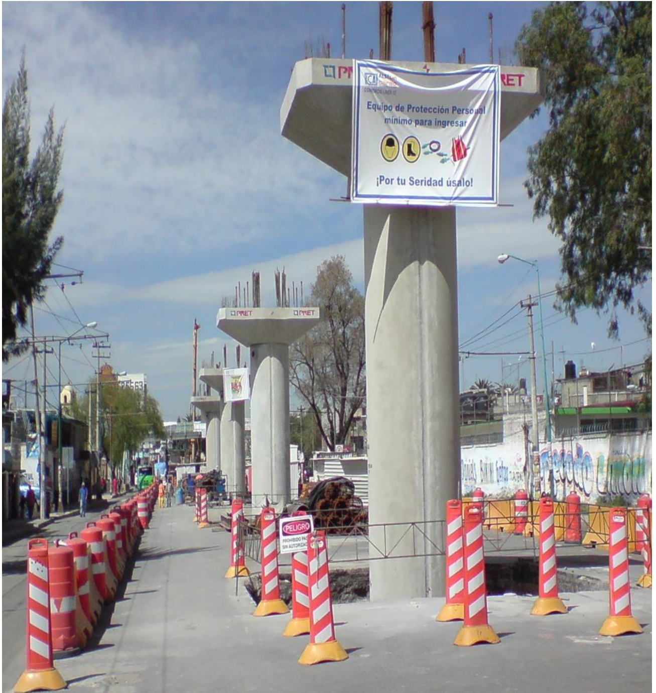
Figura IV.2.19.- Columna montada. (Foto tomada por el autor)
