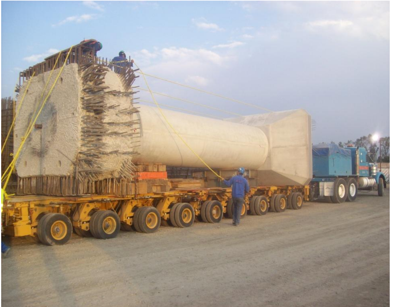
Figura IV.2.18.- Traslado para su montaje (Foto tomada por el autor)
