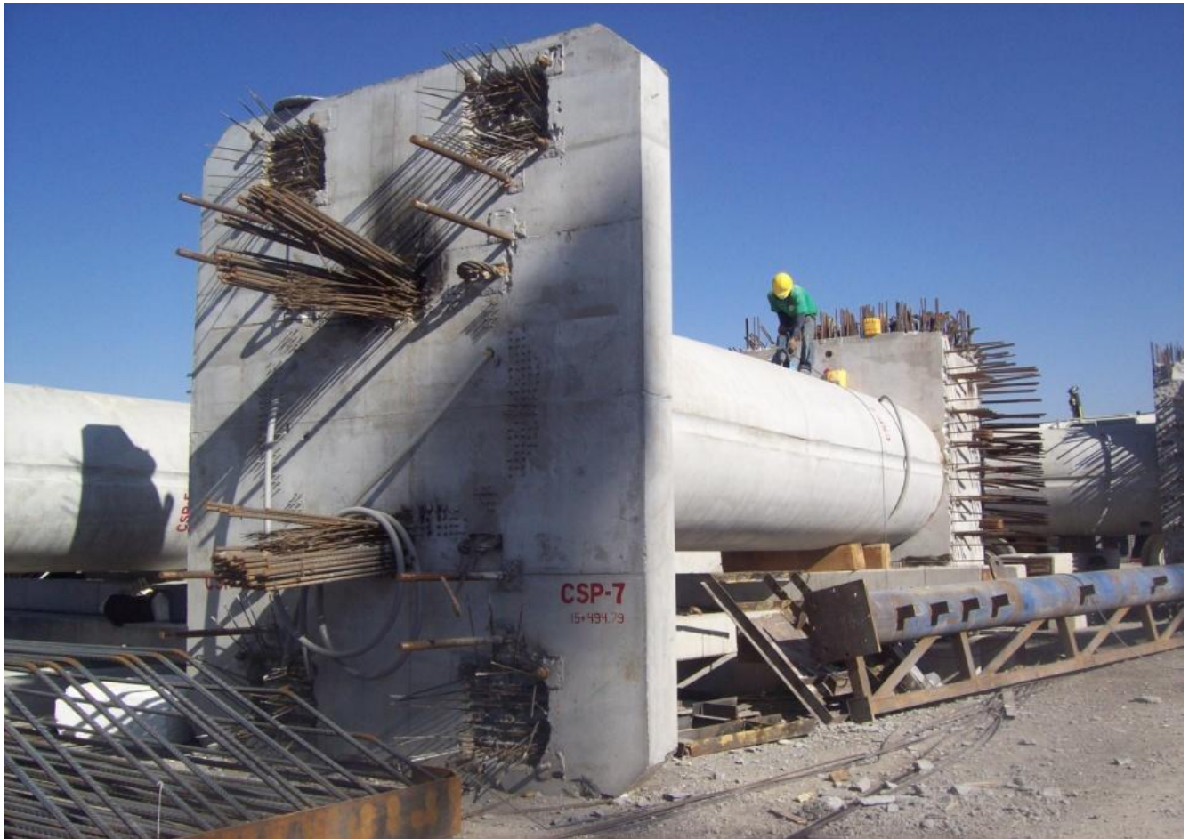
Figura IV.2.17.- Almacenaje para su detallado (Foto tomada por el autor)
