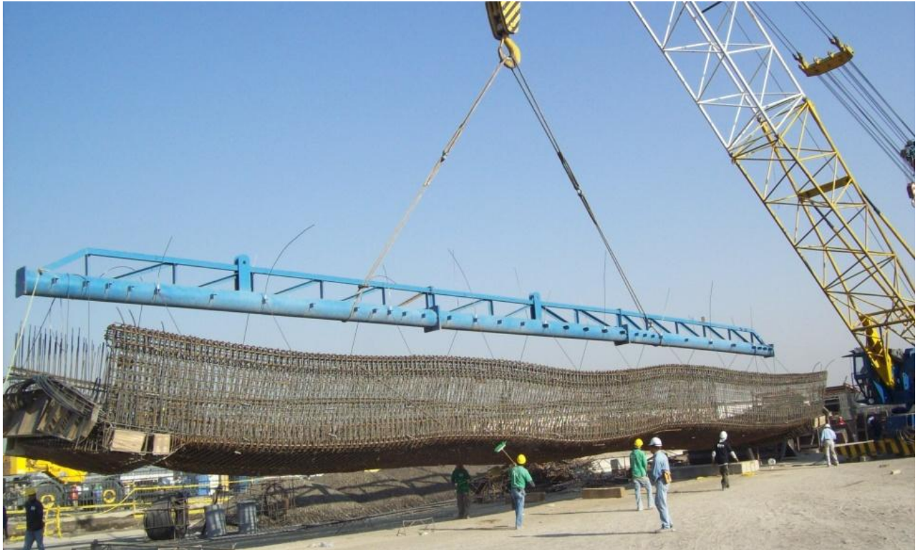
Figura IV.3.6.- Liberación del armado. (Foto tomada por el autor)
