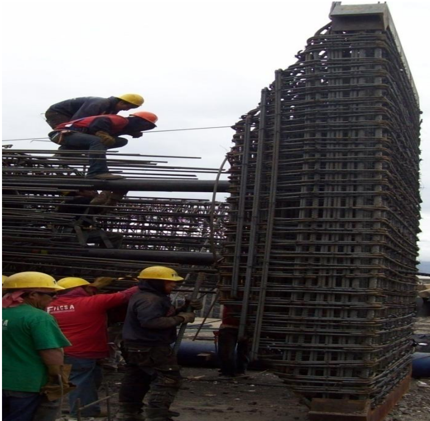
Figura IV.2.6.- Unión del Capitel con el Fuste (Foto tomada por el autor)
