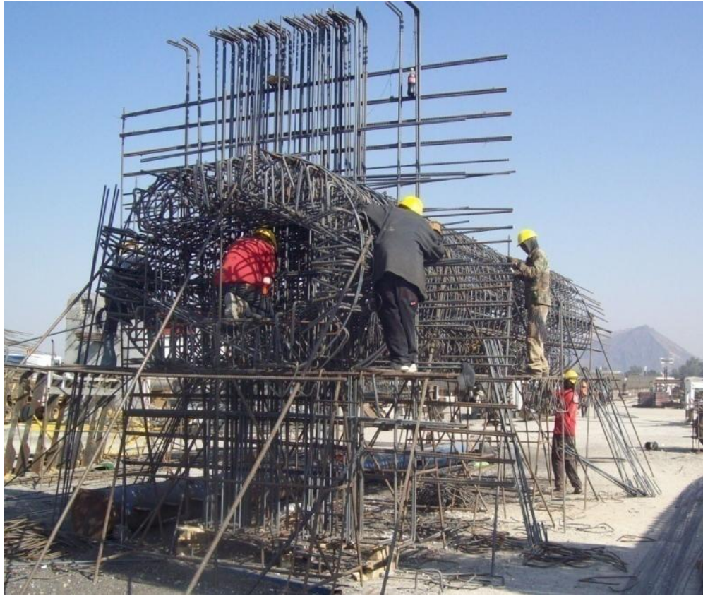
Figura IV.2.4.- Armado de zapata y fuste (Foto tomada por el autor)
