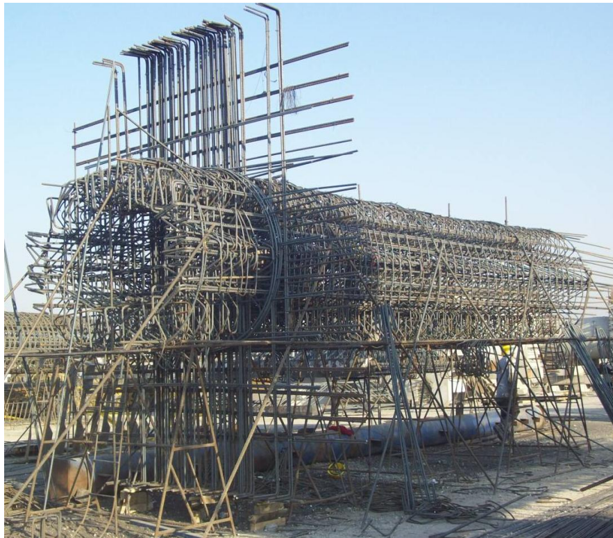
Figura IV.2.3.- Armado de acero (Foto tomada por el autor)
