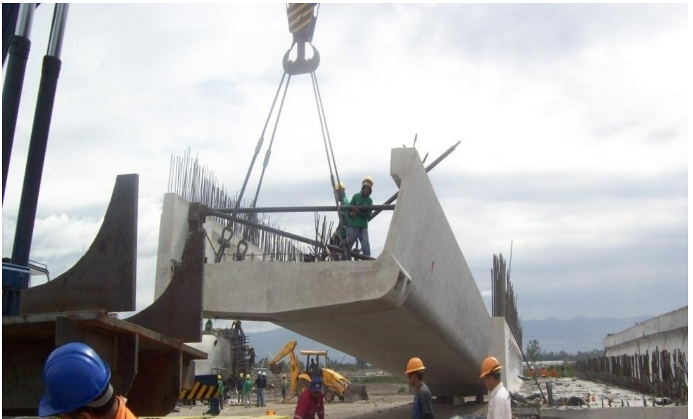
Figura IV.3.16.- Transporte-estiba. (Foto tomada por el autor)
