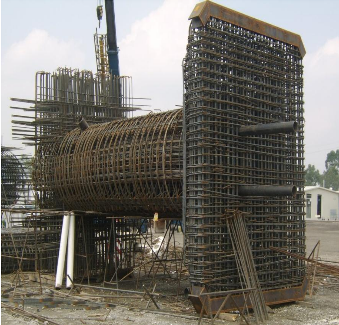
Figura IV.2.7.- Integración del capitel al cuerpo de la columna ( Foto tomada por el autor)
