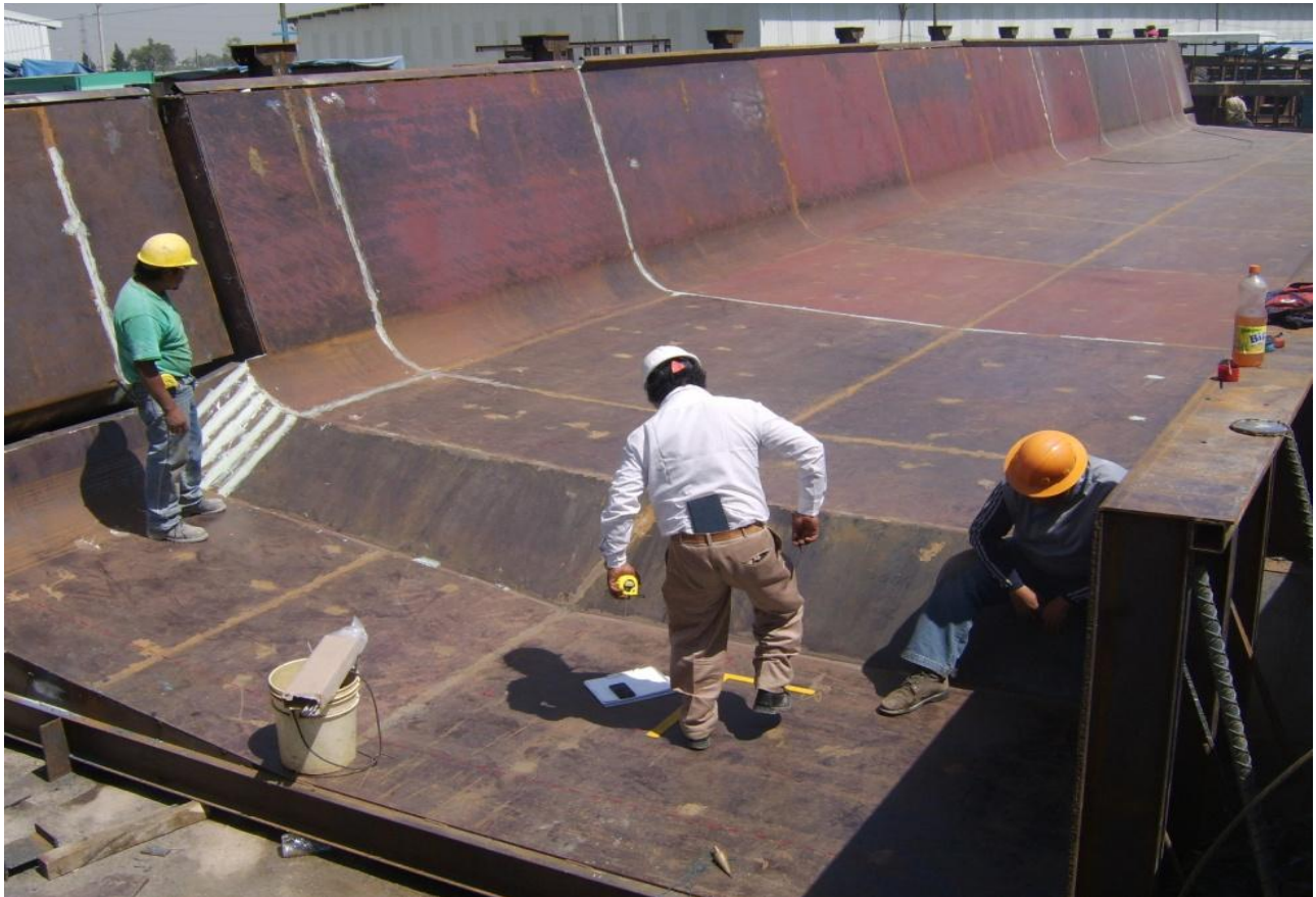
Figura IV.3.1.- Topografía del molde. (Foto tomada por el autor)
