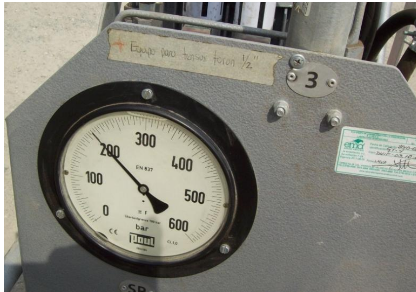
Figura IV.3.11.A Manómetro (Foto tomada por el autor)
