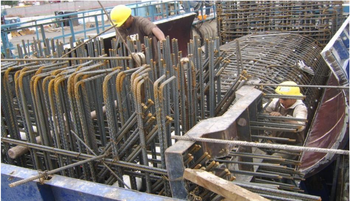
Figura IV.2.11.- Elemento dentro del molde listo para el colado (Foto tomada por el autor)
