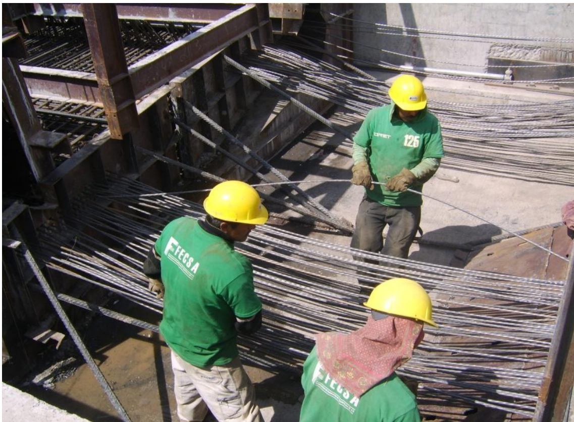
Figura IV.3.7- Introducción del torón. (Foto tomada por el autor)
