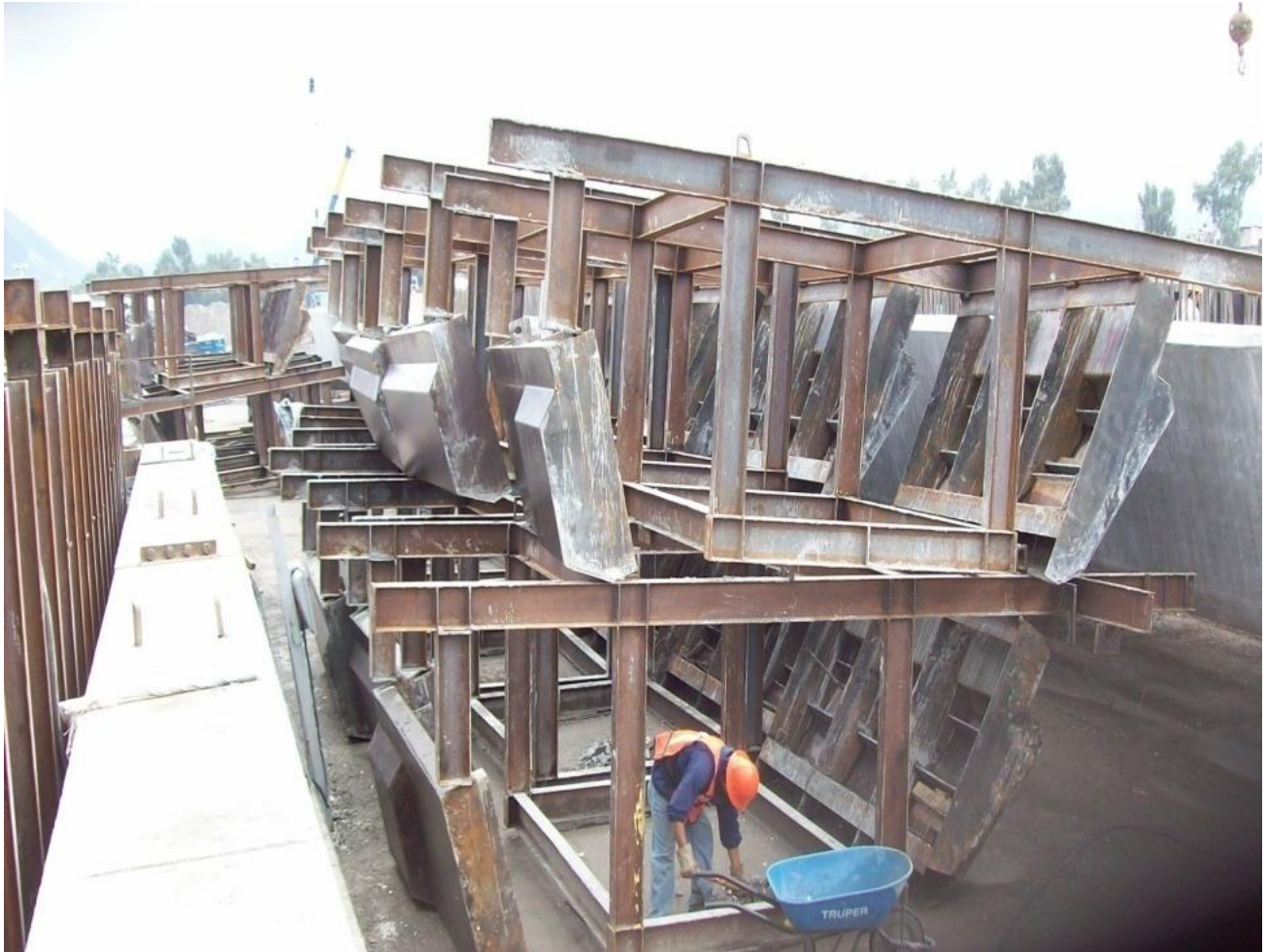
Figura IV.3.9.- Cimbra flotante. (Foto tomada por el autor)
