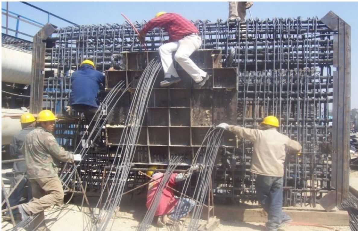
Figura IV.2.9.- Introducción del torón (Foto tomada por el autor)
