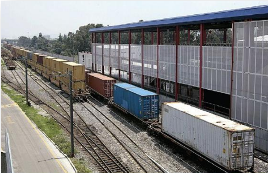
Central Ferrovalle que conecta la aduana de Pataco
