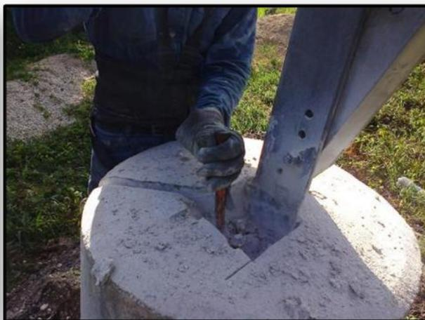
Imagen 29 y 30. Corte y demolición de concreto durante los trabajos de MSPT en estructuras de la GRTP – 2014.
