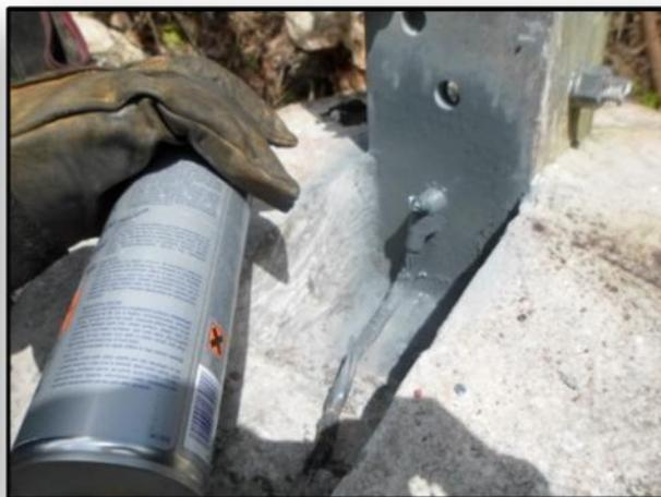
Imagen 35 y 36. Aplicación de recubrimiento anticorrosivo durante los trabajos de MSPT en estructuras de la GRTP – 2014.
