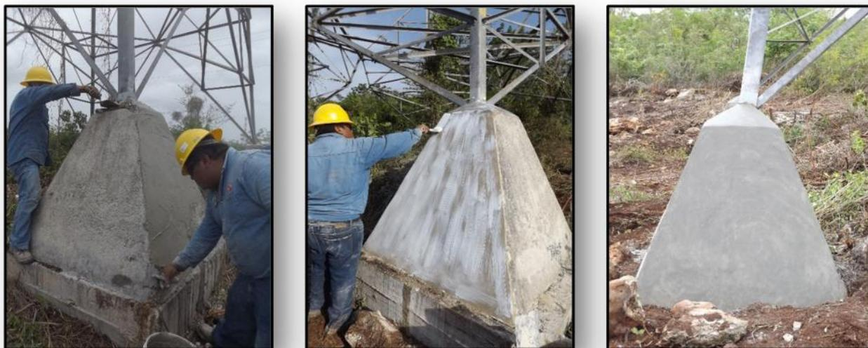
Imágenes 43 - 45. Reposición de concreto demolido durante los trabajos de MSPT en estructuras de la GRTP – 2014.
