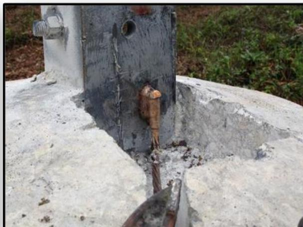
Imagen 33 y 34. Aplicación de soldadura exotérmica durante los trabajos de MSPT en estructuras de la GRTP – 2014.
