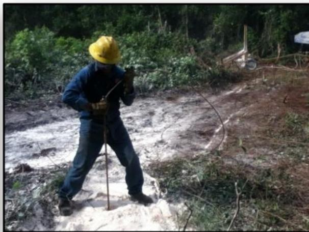
Imagen 37 y 38. Colocación de cable y electrodos copperweld durante los trabajos de MSPT en estructuras de la GRTP – 2014.
