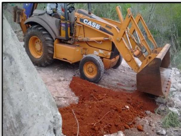
Imagen 41 y 42. Relleno y compactación de zanjas durante los trabajos de MSPT en estructuras de la GRTP – 2014.
