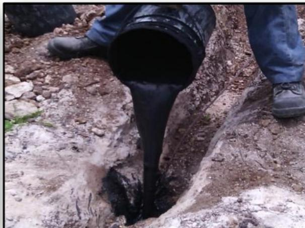
Imagen 39 y 40. Aplicación de Intensificador químico durante los trabajos de MSPT en estructuras de la GRTP – 2014.
