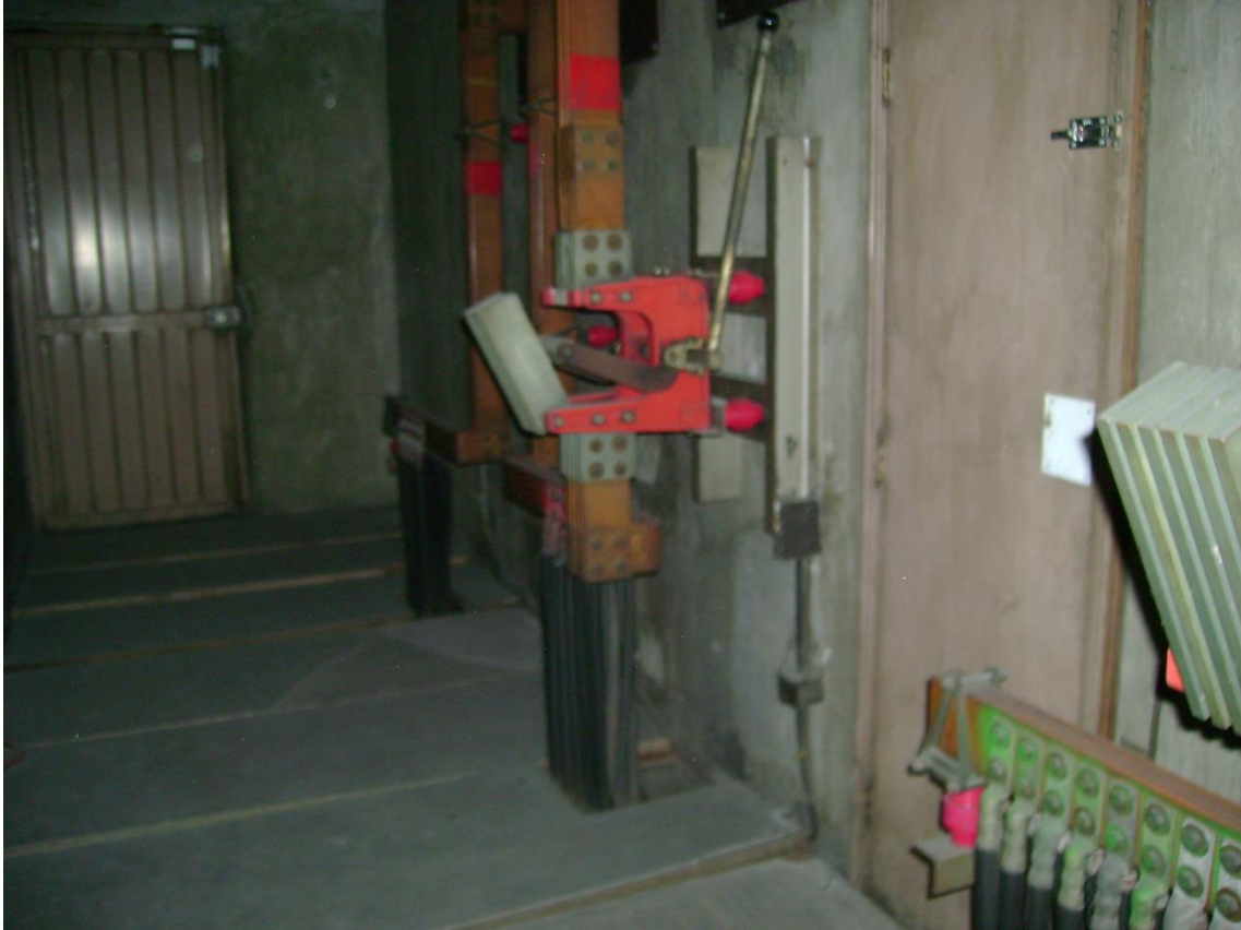
Figura 4-18 Seccionador 8000 Amperes.
