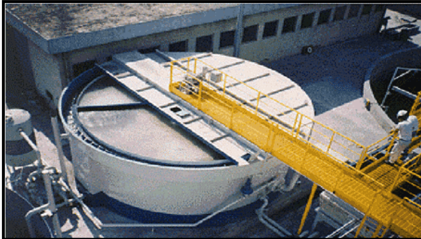
Figura 1.21 Tanque de flotación de cuarta generación (Eades, et al 2001).
