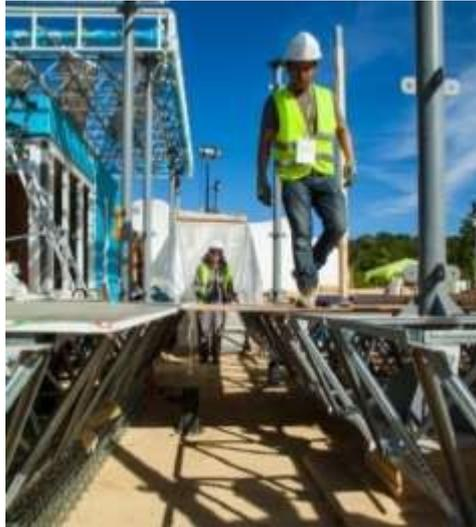
**Fig. 24.** Sistema estructural de piso y techo.
