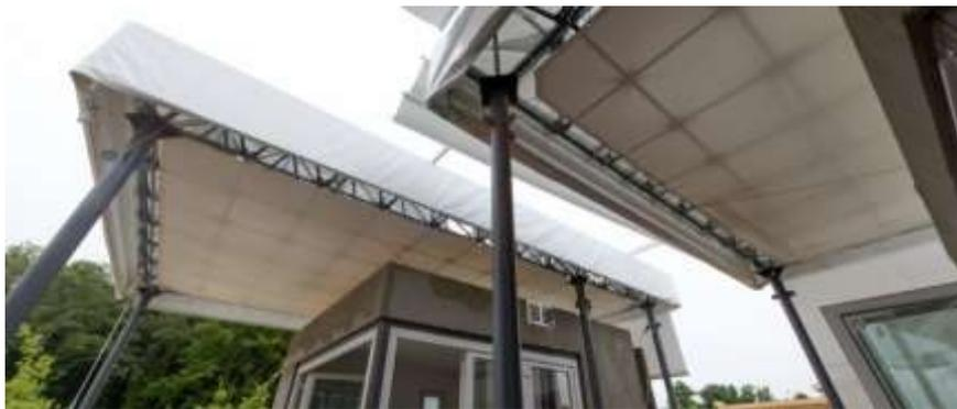
**Fig. 28.** Sistema de captación pluvial.
