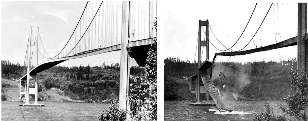
Figura 1- 2 Colapso del puente Tacoma Narrows
