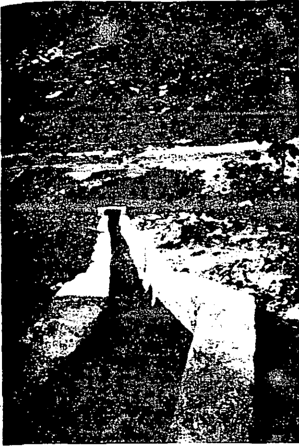
Un lavadero de mampostería, con plantilla de acero, en correcto funcionamiento.
