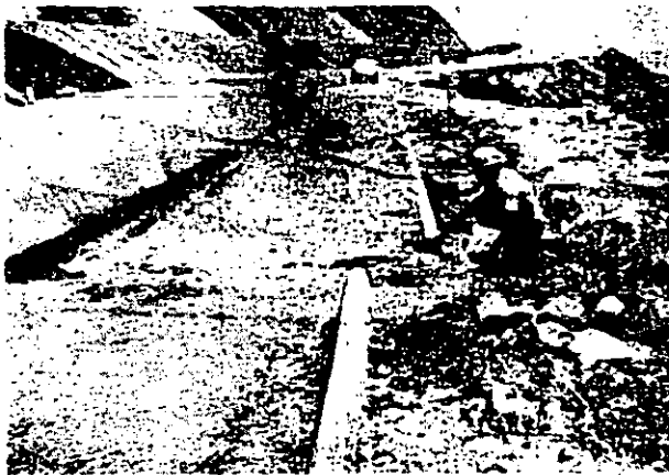
Otra vista del efecto de la deformación lenta sobre una superficie de falla previamente formada. (Autopista Tijuana-Ensenada.)
