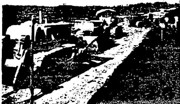
Halado de escarpa con tractor.
