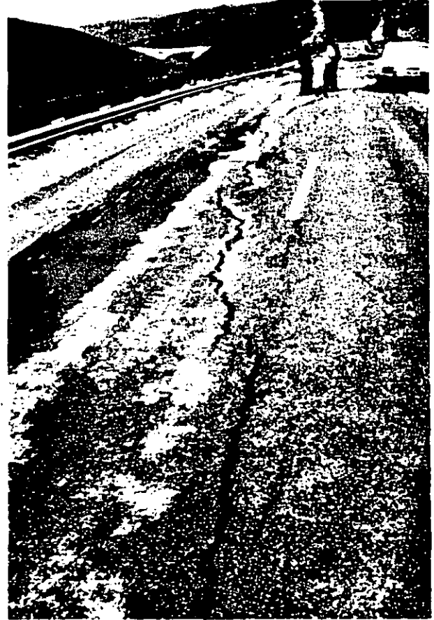
Grietas longitudinales en un terraplén. (Carretera Apaseo-Irapuato.)
