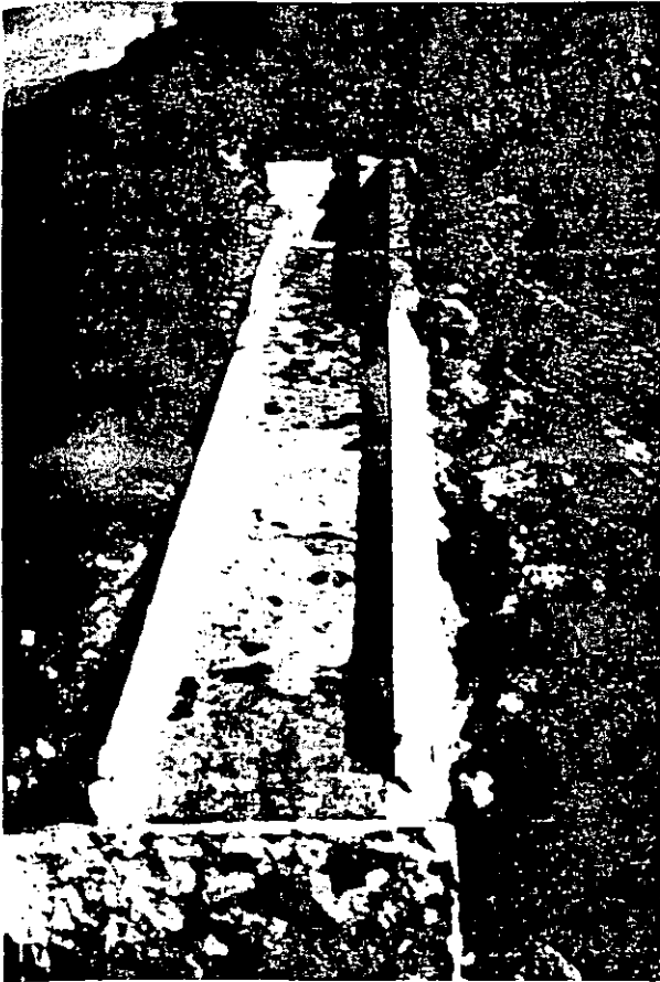
Una bajada para defensa de la salida de una alcantarilla.
