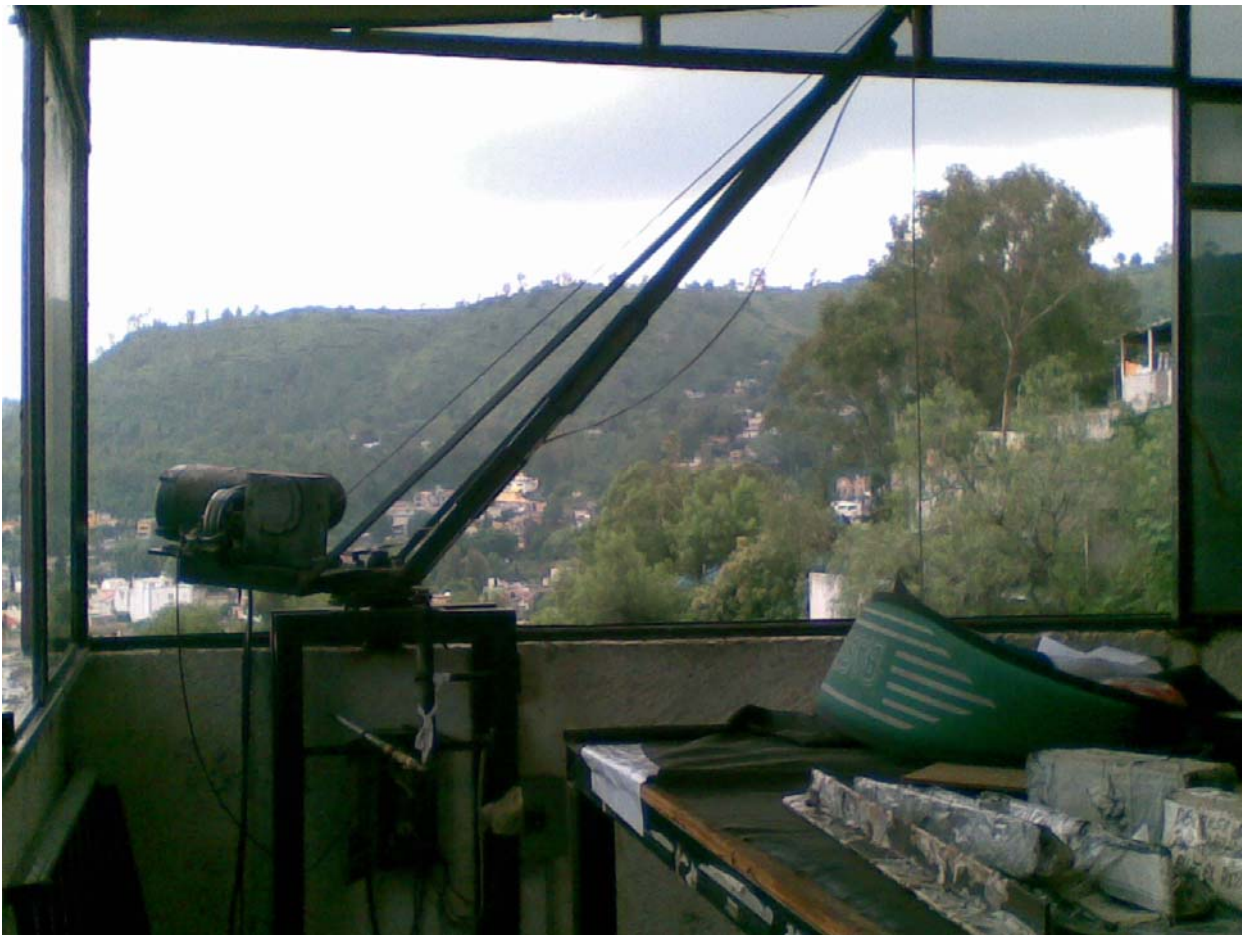
Imagen 16 Grúa utilizada para subir las materias primas.
