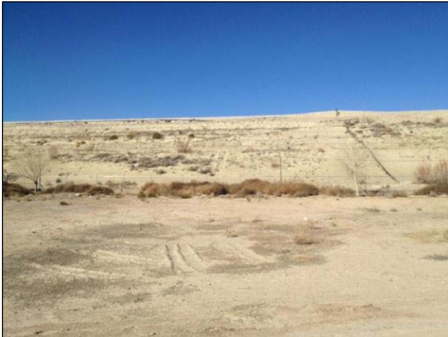
Figura 8. Talud del depósito con jales expuestos por las corrientes eólicas
