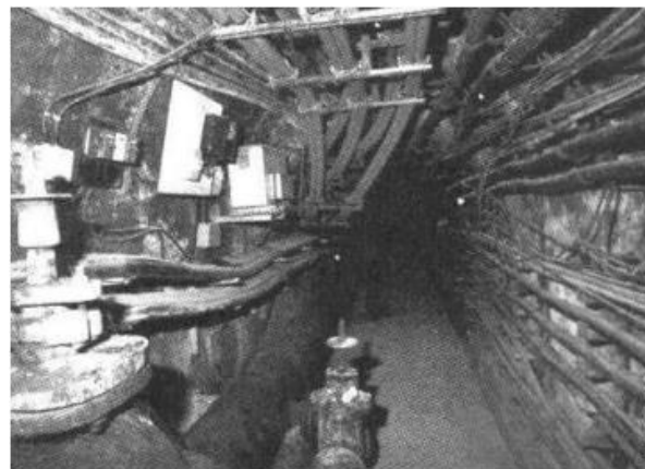
Fig 2.16 Túneles para galería de servicios (Soto, 2004).
