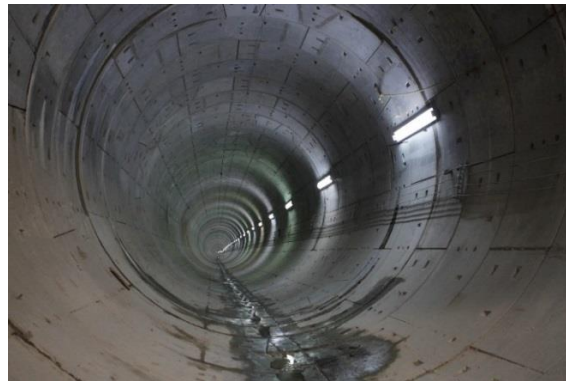
Fig 2.5 Dimensión de un túnel para drenaje profundo (fuente: http://fuerza.com.mx/2014/07/27/inician-construccion-de-tunel-que-terminara-con-inundaciones-en-valle-de-chalco/ , 2015).
