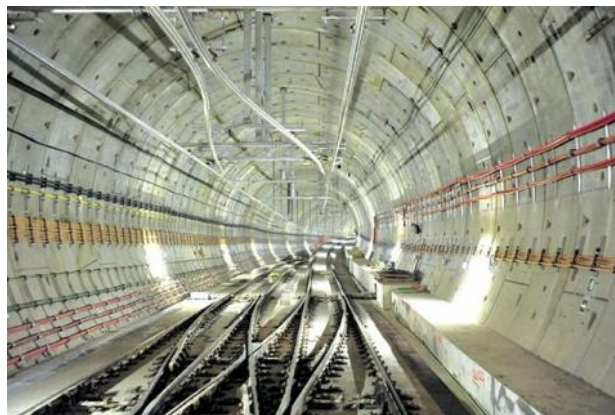
Fig 2.12 Túnel de la línea 9 del metro de Barcelona (fuente: http://magazine.sener.es/news/continua-la-integracion-de-la-linea-9-del-metro-de-barcelona/46/ , 2013).
