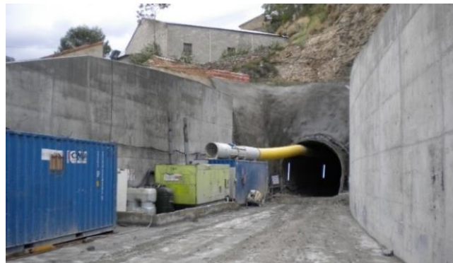
Fig 2.14 Acceso de un túnel hidráulico (fuente: http:// www.tierraminera.wordpress.com/obra/civil , 2011).
