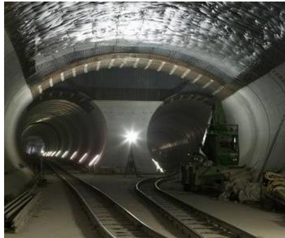
Fig 2.9 Túnel de ferrocarril de Saint-Gothard, Suiza (fuente: http:// www.nemetscheck-allplan.fr , 2015).
