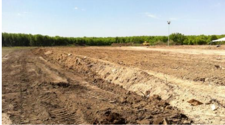
Fig 2.2 Tipo de terreno para la construcción (fuente: http://www.arqhys.com/construccion/tierra-relleno.html , 2015).
