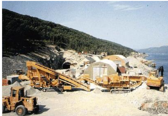
Fig 2.31 Túnel Kvalsund en construcción (Junca, 1990).
