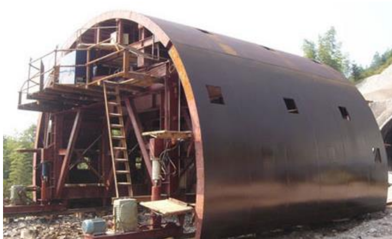
Fig 2.7 Sistema de encofrado del túnel (Fuente: http://www.rollingmachinery.com.es/index.html,2014 ).
