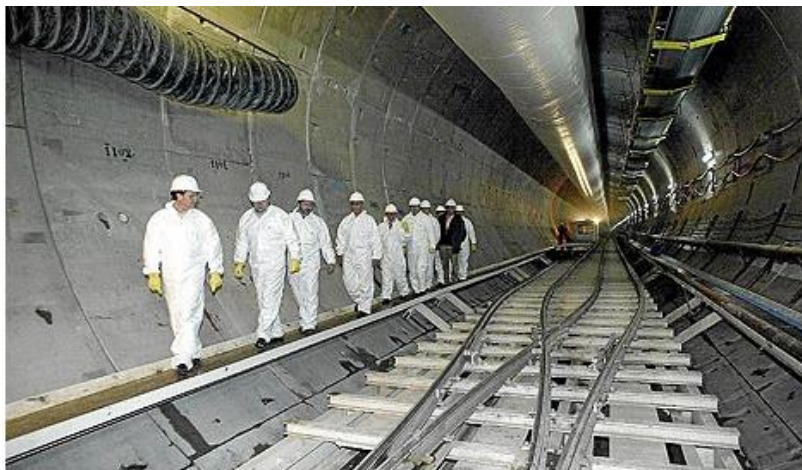
Fig 2.34 Interior de uno de los túneles de Guadarrama (fuente: http:// www.elmundo.es , España, 2007).
