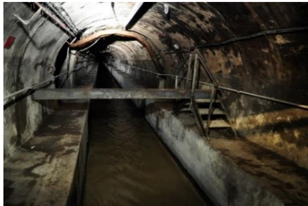
Fig 2.15 Túneles de alcantarillado en París (fuente: http://www.paris.es/museo-alcantarillado , 2015).
