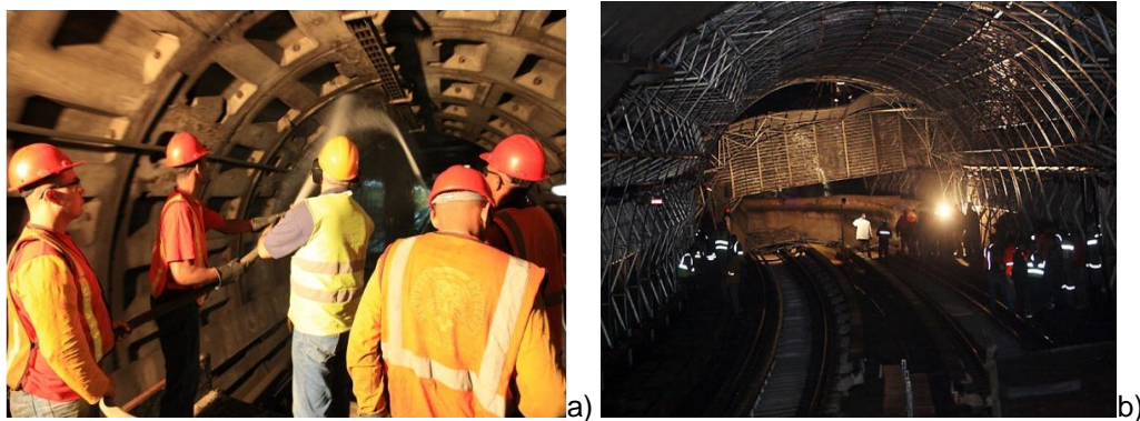
Fig 2.35 Trabajos de mantenimiento: a) personal técnico y especialistas en vías férreas realizando labores de limpieza y mantenimiento; b) trabajos de sustitución de mantenimiento mayor en la Línea 1 del Metro de Caracas (fuente: http:// www.correodelorinoco.gob.ve , 2011).
