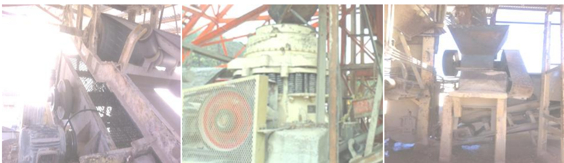
Figura 6.8 De izquierda a derecha: banda transportadora, quebradora de quijada y alimentador a jigs.
