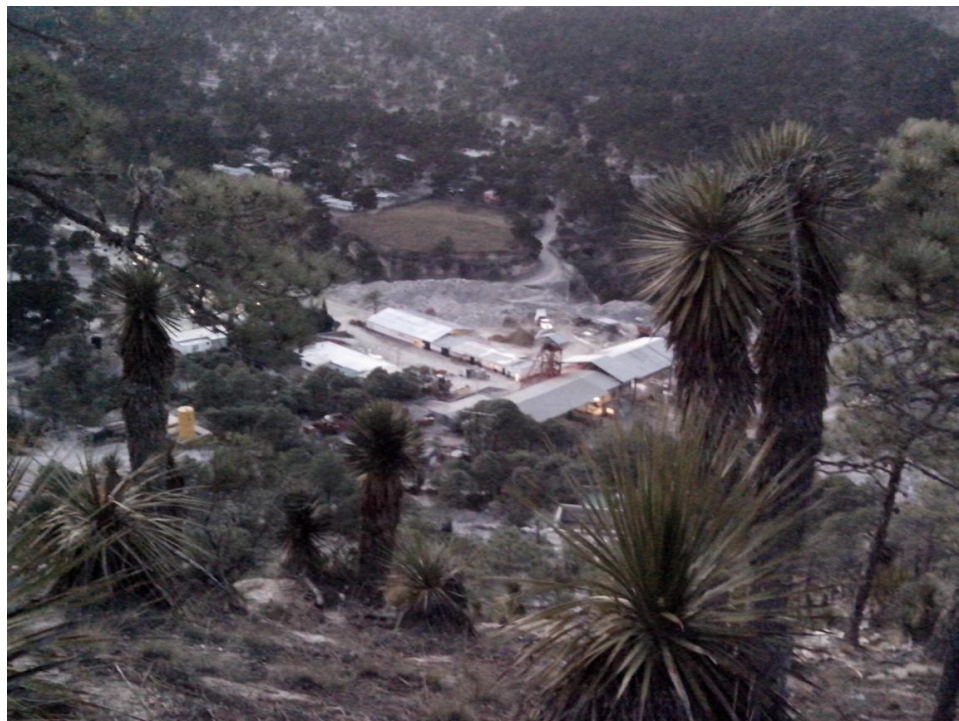
Figura 7.7 Al centro se observa el tiro 1, planta, laboratorio, almacén, taller de mantenimiento y parte de las oficinas.
