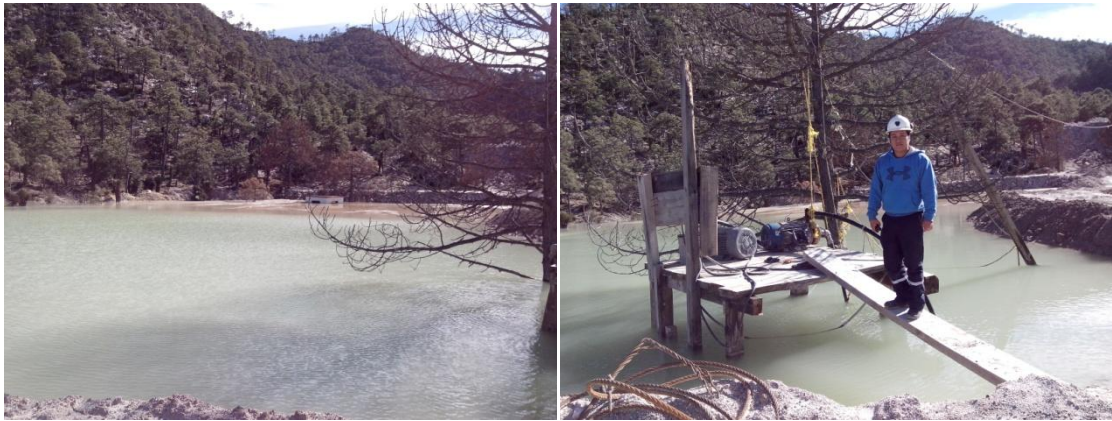
Figura 7.3 A la izquierda se presenta vista del espejo de agua. A la derecha se muestra el sistema de bombeo del depósito de residuos mineros.
