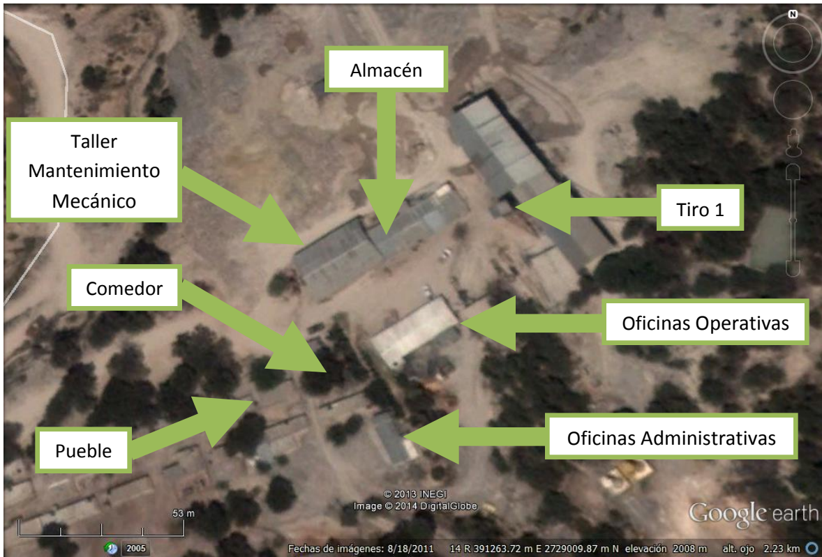
Figura 7.6 Instalaciones de servicio: oficinas, almacén, taller y comedor industrial. [20]
