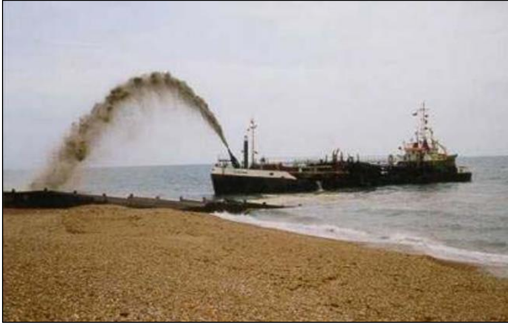
Figura 3.2 Relleno de playa por bombeo de arena
