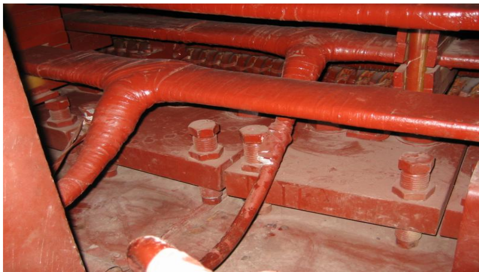
Figura 26. Conexión al bus
