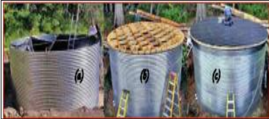
Figura 4.12 (a) Ensamblado de las hojas de lámina galvanizada con tornillos, (b) Estructura para el techo del tanque y (c) Colocación de material impermeable para evitar las pérdidas del agua por evaporación. (a) (b) (c). (D. Phillips y col., 2006)
