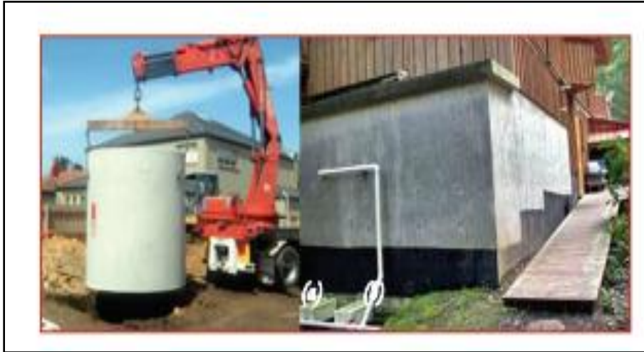
Figura 4.9 Transporte de cisterna de concreto: (a) 5 m 3 y (b) 75,6 m 3 (D. Phillips y col., 2006)
