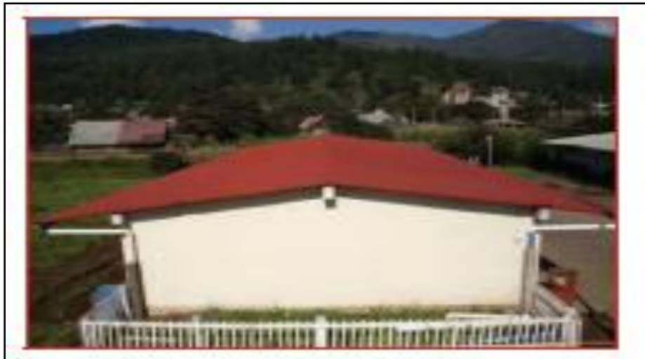
Figura 4.2 Techos de escuelas utilizados como áreas de captación del agua de lluvia. (D. Phillips y col., 2006)
