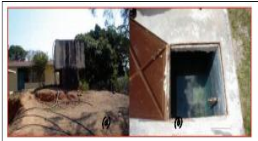
Figura 4.10 (a) Cisterna de cemento tabique: escuela primaria de Acapulco, (b) y tapa de protección, Estado de México. (D. Phillips y col., 2006)
