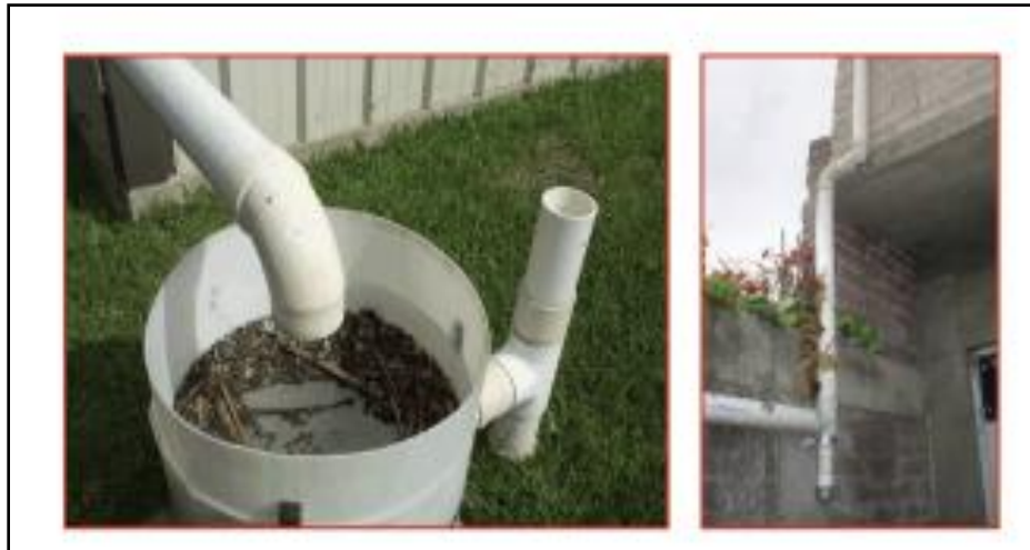
Figura 4.16 Trampa de basura para las primeras lluvias (izquierda) y válvula para drenaje (derecha) (D. Phillips y col., 2006).
