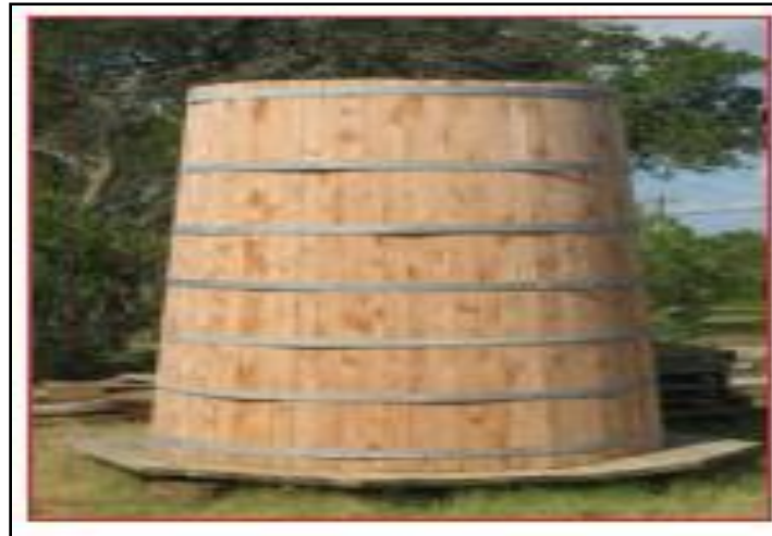
Figura 4.14 Cisterna de madera de pino con tensores para almacenar 5 m 3 . (D. Phillips y col., 2006).
