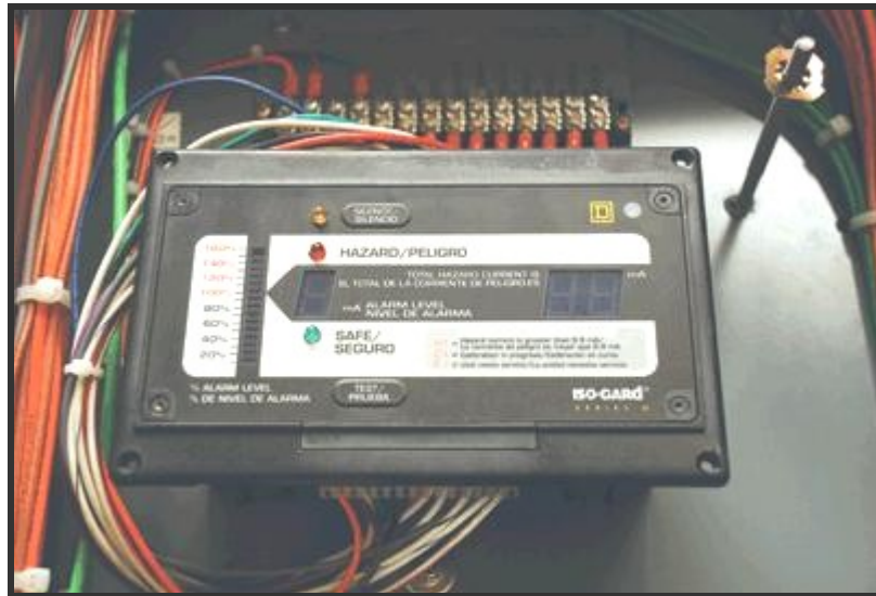
Figura 5.9: Monitor de Aislamiento de Línea
