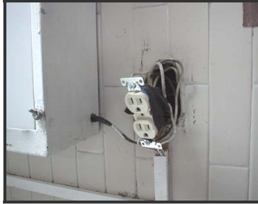
Figura 5.16: Receptáculo dentro del área de quirófano.
