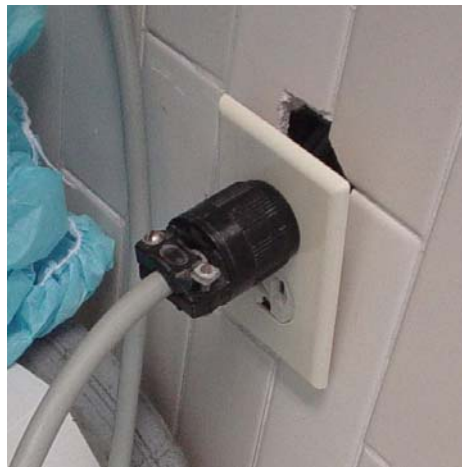
Figura 5.19: El receptáculo no cumple con la característica de ser grado hospital.
