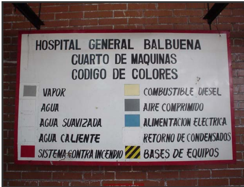
Figura 3.10: Cuarto de Máquinas
