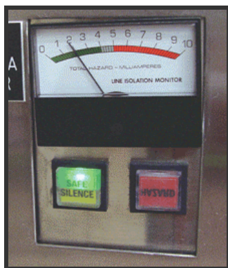
Figura 6.17: Señalización del monitor de aislamiento de línea.
