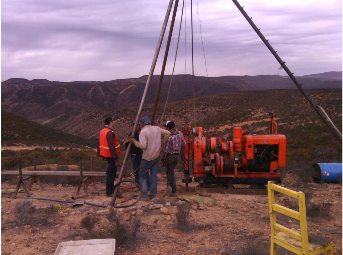
Fig. 3-3 Equipo de perforación Longyear para barrenación y extracción de núcleo
