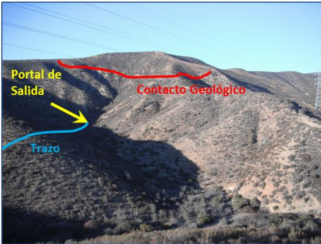
Fig. 4-1 Imagen panorámica que muestra el contacto geológico entre la Formación San Diego y Rosario Inferior con respecto al portal de salida del Túnel Olivares
