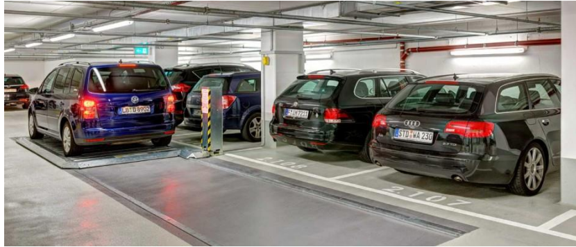
Figura 17 Plataforma sobre rieles.
