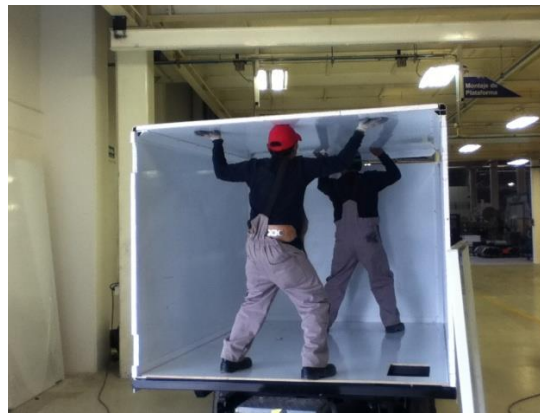
Figura 22. Instalación de paneles laterales y techo.
