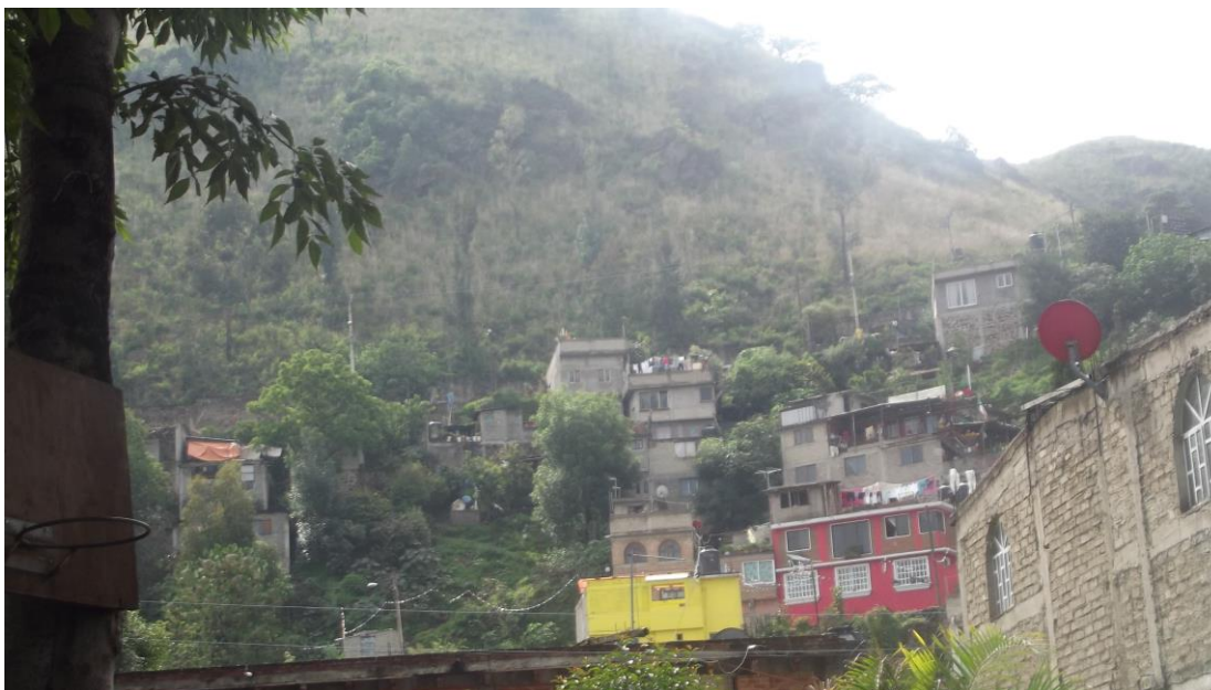
Fotografía 20. Localidad Ampliación Las Peñitas donde se muestra un conjunto de viviendas dentro de la zona de caída de rocas y flujos de lodo. (19.2319° N, 99.0897° W. Calle: Camino Real).
