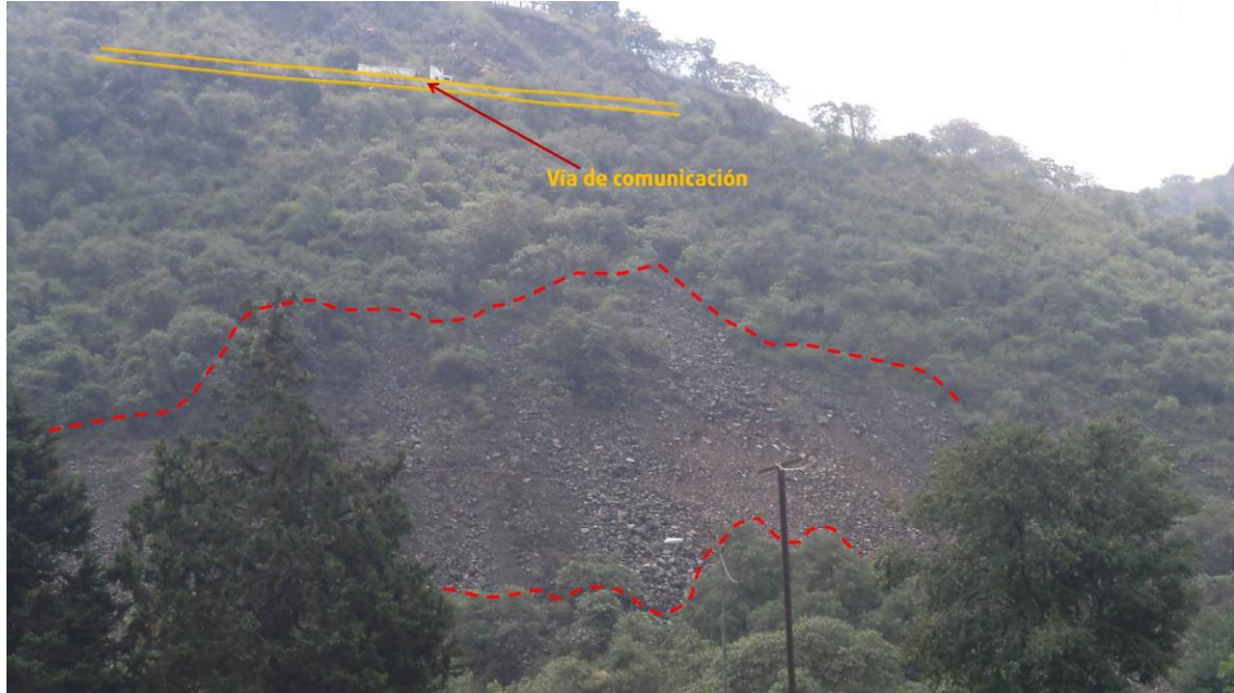
Fotografía 1. Se muestra la caída de roca provocada por la construcción de la carretera México–Cuernavaca. (19.2262° N, 99.1387° W. Calle: Camino a la Cantera).
