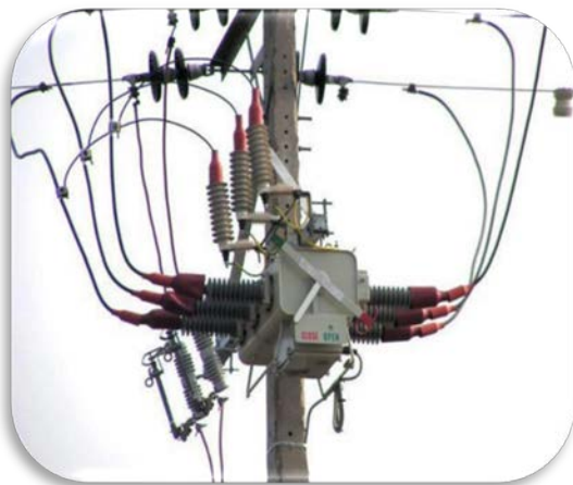
Figura 2.8. Seccionador instalado en una línea de media tensión
