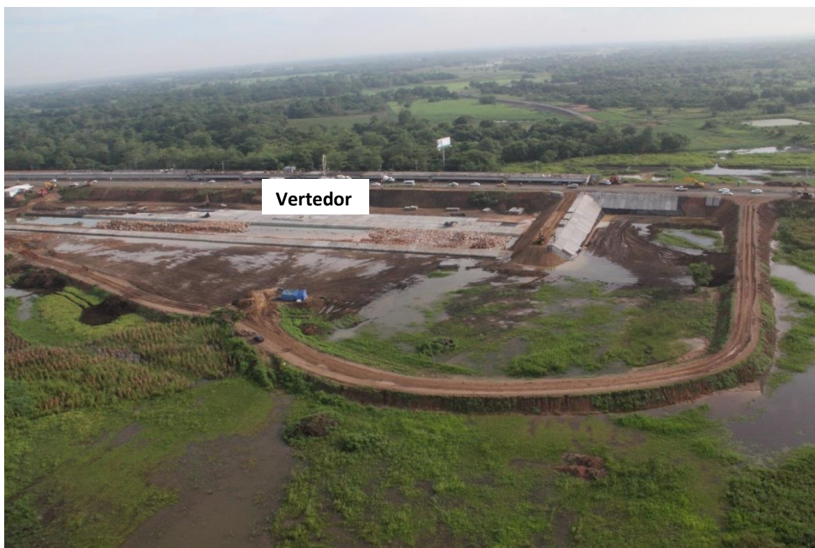
FIGURA 3.1.1.5 VISTA AÉREA DEL VERTEDOR Y LA ZONA CON VEGETACIÓN Densa (FUENTE: INSTITUTO DE INGENIERÍA UNAM)
