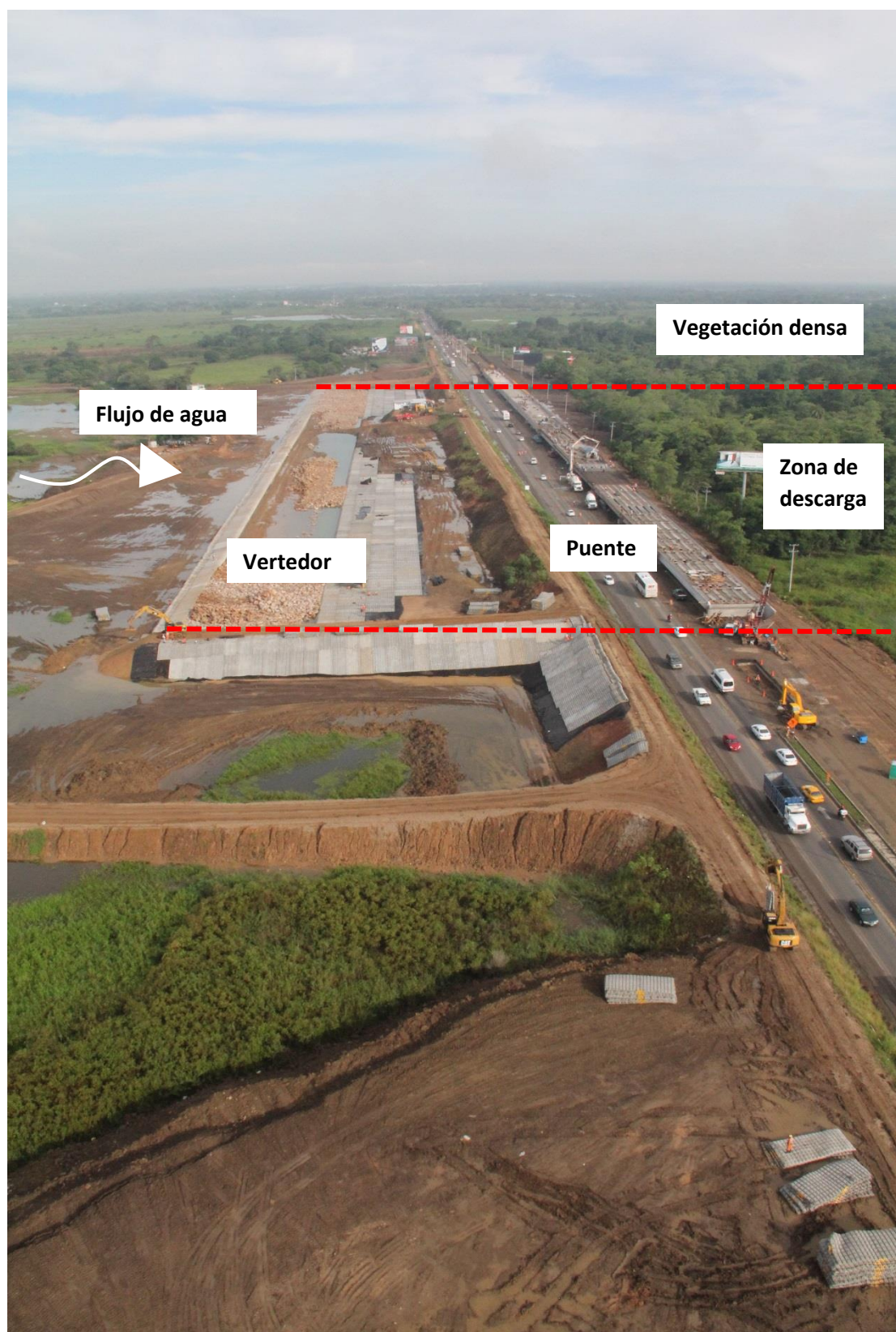
FIGURA 3.1.1.6 VISTA AÉREA DEL VERTEDOR LADO ESTE (FUENTE: INSTITUTO DE INGENIERÍA UNAM)
