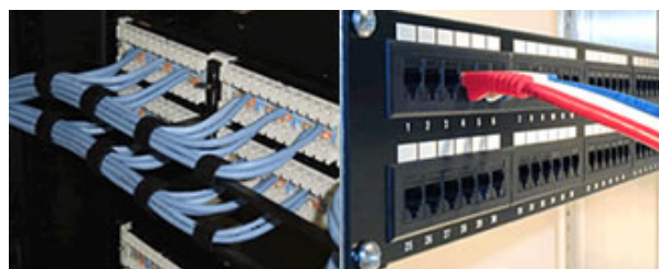
Figura 5.12. Paneles de Parcheo.
