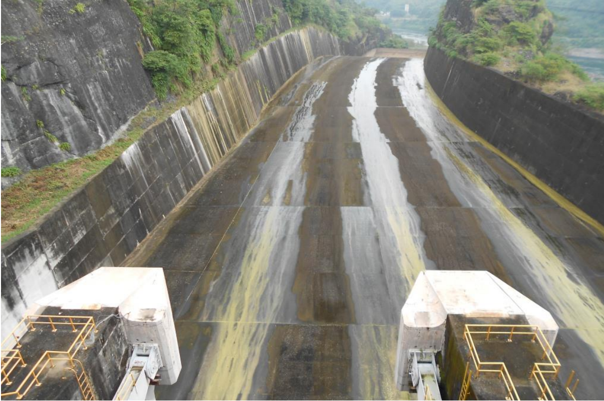
Figura 3.16 Vertedor de emergencia original
