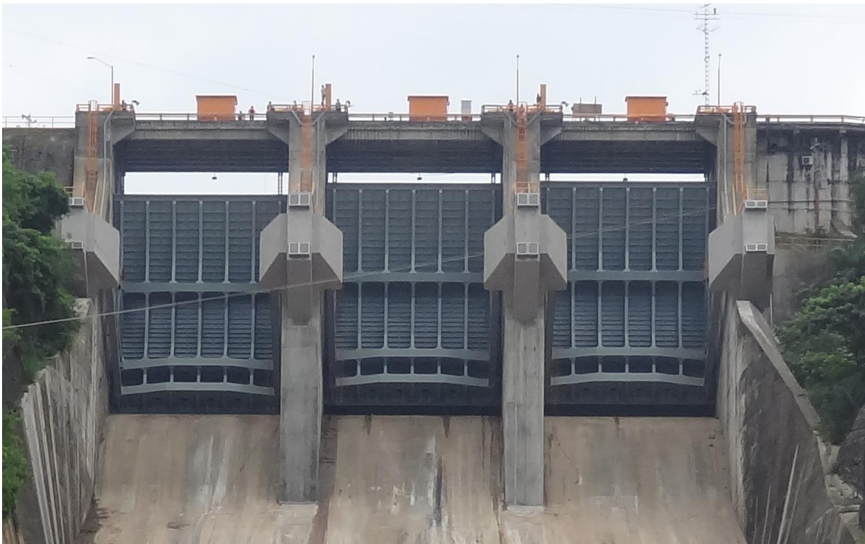
Figura 3.9 Reforzamiento de Compuertas y vigas testeras
