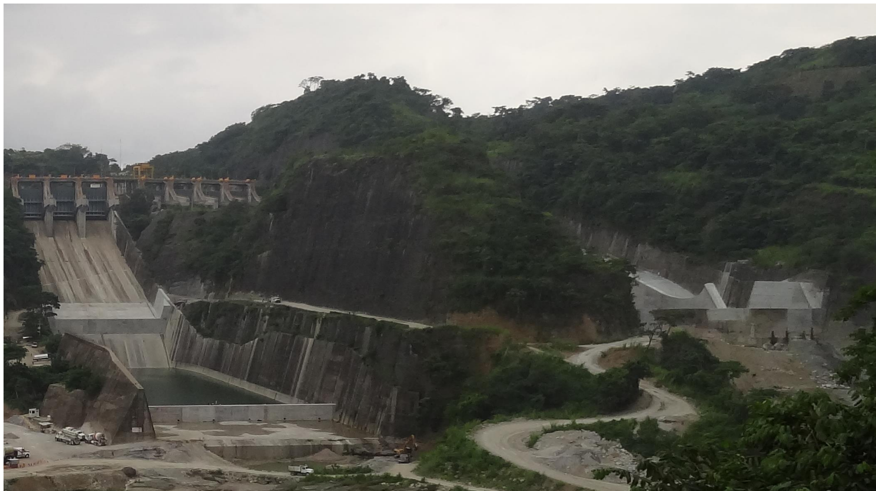
Figura 3.27 Obra de excedencias de la presa Netzahualcōyotl en la actualidad
