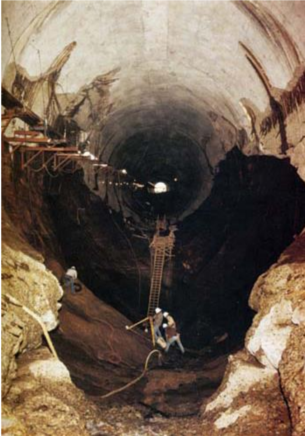
Figura 2.10 Túnel del vertedor de la presa Glen Canyon. Sep. 1983 (Falvey, 1990)
