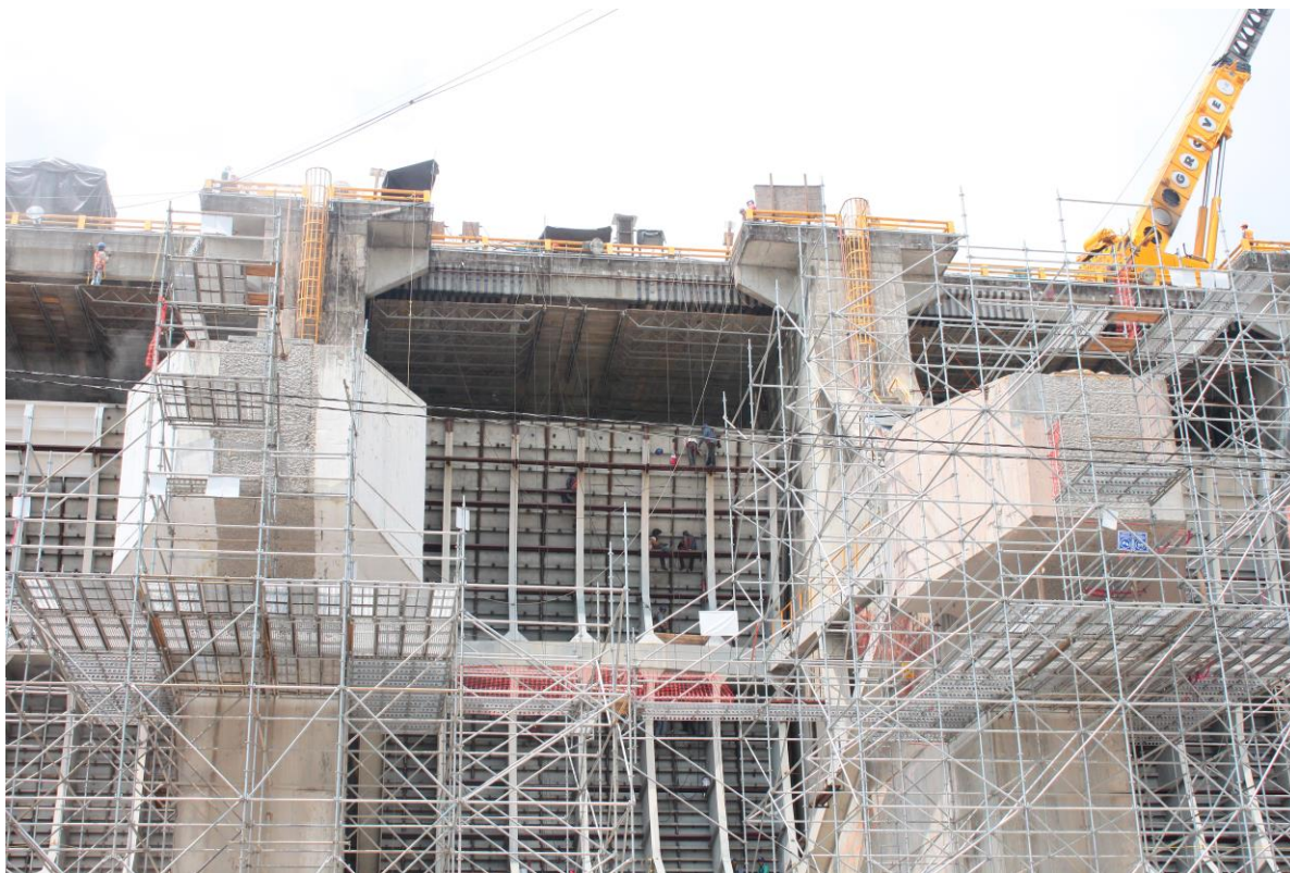
Figura 3.23 Reforzamiento de compuertas y vigas testeras
