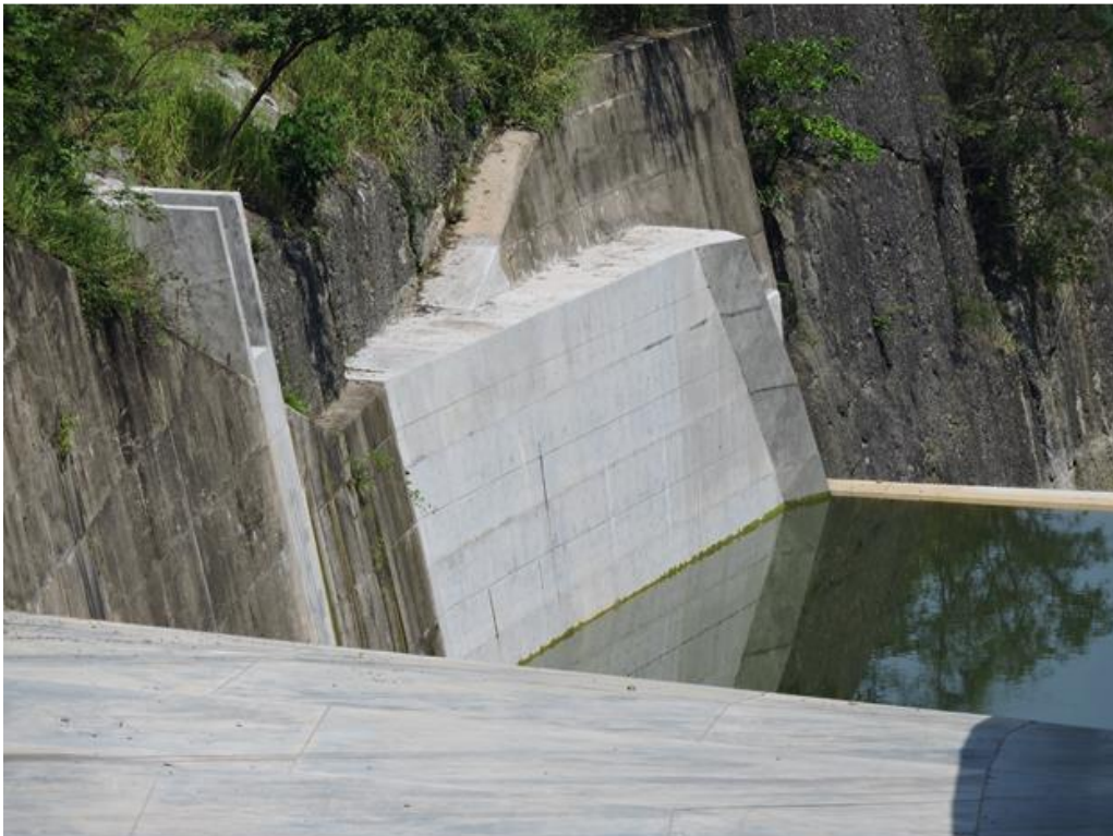
Figura 3.36 Transición de muro y deflectores laterales
