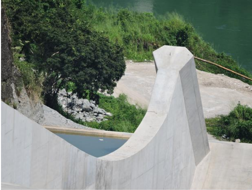
Figura 3.37 Deflectores en muro central
