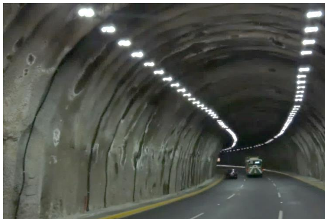
Figura 2.8. Revestimiento de concreto lanzado. Túnel Supervía Poniente, México (Cortesía Consultec).
