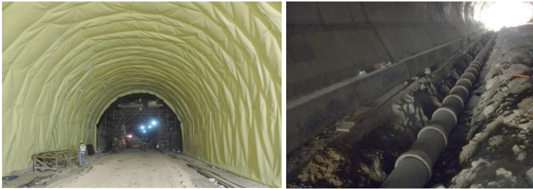
Figura 4.4. Sistema de impermeabilización y drenaje.
