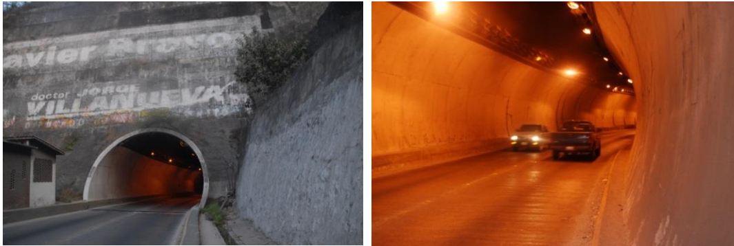
Figura 1.13. Túnel del Libramiento Puerto Vallarta, (Cortesía: M.I. J. Francisco Suárez Fino).
