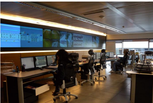
Figura 6.12. Centros de control
