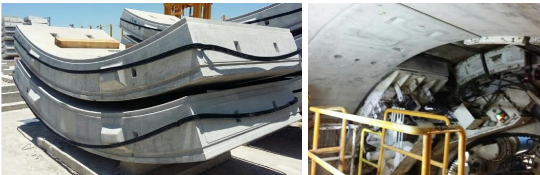
Figura 2.22. Habilitado de dovelas y colocación.
