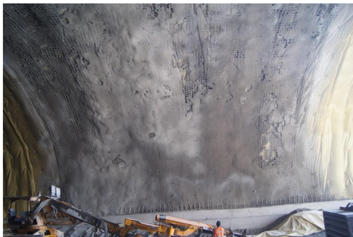
Figura 7.2. Colocación de concreto lanzado simple como revestimiento definitivo. Túneles Chimalpa I y II. (Cortesía Consultec).
