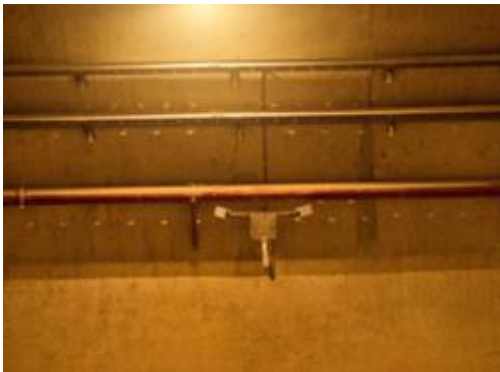
Figura 6.10. Detección y extinción de incendios
