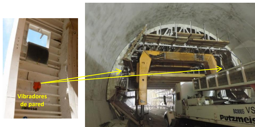
Figura 5.4. Cimbra deslizante para colado de concreto, Túnel Interlomas México, (Cortesía Consultec).
