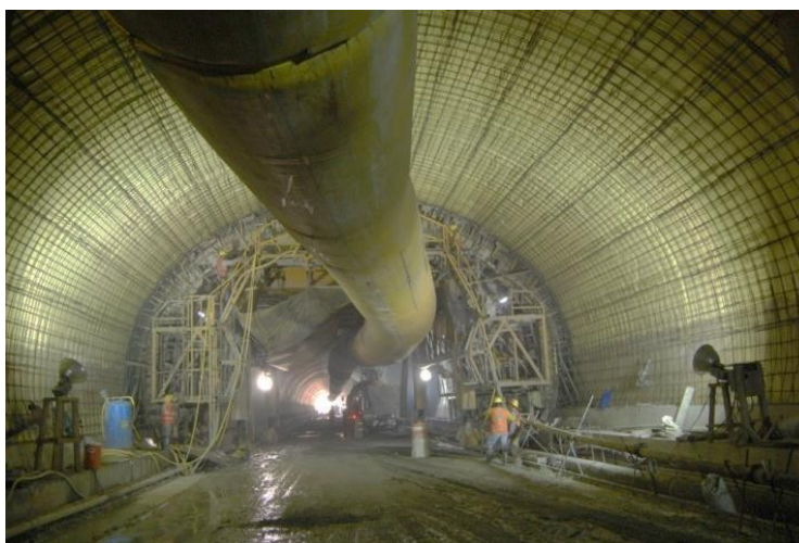
Figura 7.18. Colado del revestimiento de concreto hidráulico con acero de refuerzo.
