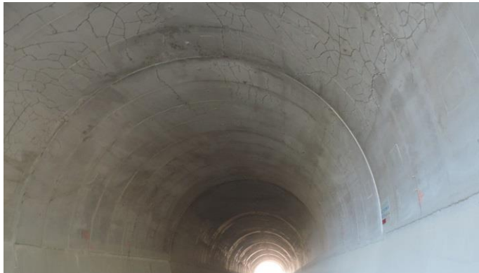
Figura 4.8. Revestimiento de concreto hidráulico, Túnel Interlomas, México.
