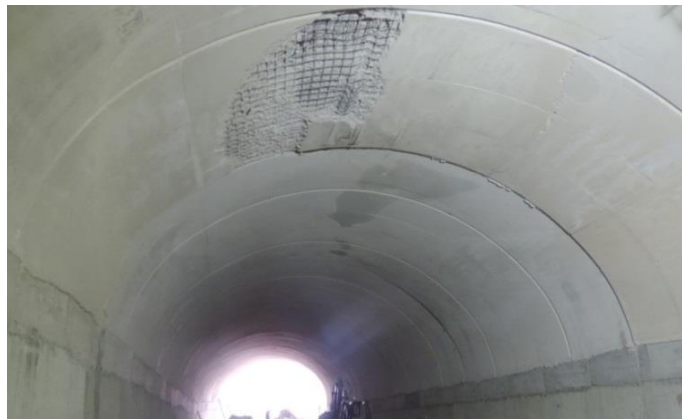
Figura 4.9. Revestimiento de concreto hidráulico, Túnel Interlomas, México.
