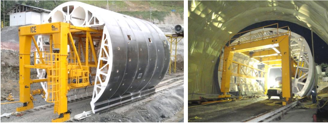
Figura 2.17. Cimbra metálica para revestimiento en túneles carreteros.
