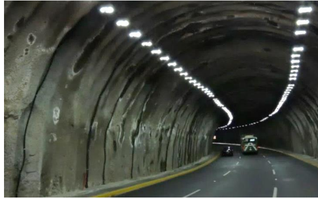
Figura 2.2. Túnel revestido con concreto lanzado, Supervía Poniente, México.
