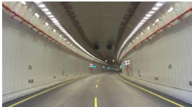
Figura 2.4. Revestimiento a base de paneles prefabricados, proyecto: Túnel Folgoso, Galicia España. Tomada de Alliance, Ref. [26].
