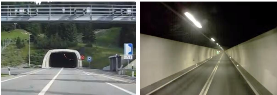
Figura 1.7. Túnel San Bernardino. Ref. [8].
