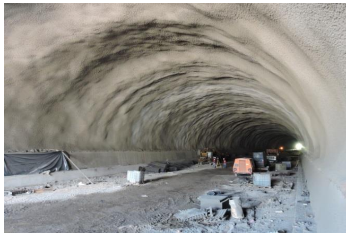
Figura 7.9. Acabado final del revestimiento de concreto lanzado.
