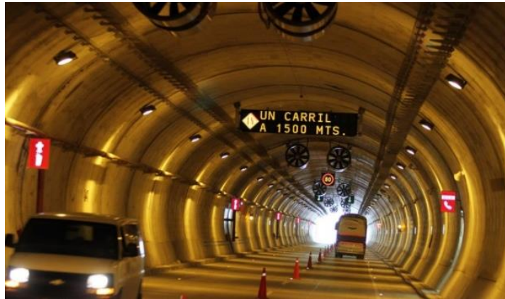
Figura 1.24. Revestimiento de los Túneles México-Tuxpan, (Cortesía: M.I. J. Francisco Suárez Fino).
