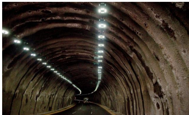
Figura 2.10. Revestimiento de concreto lanzado, Túnel Supervía Poniente, México. (Cortesía Consultec).
