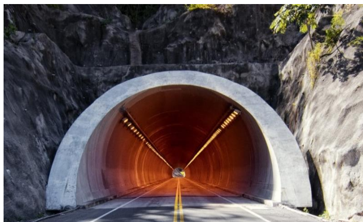
Figura 2.1. Revestimiento de concreto hidráulico, Túnel en la autopista Durango Mazatlán, México.
