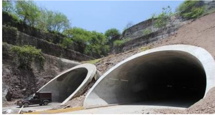
Figura 1.26. Portales del nuevo túnel de acceso a Puerto Vallarta Jalisco, México. Ref. [22].
