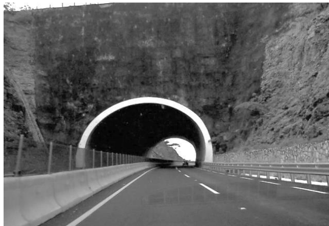
Figura 1.15. Túnel Los Querendes. Ref. [15].
