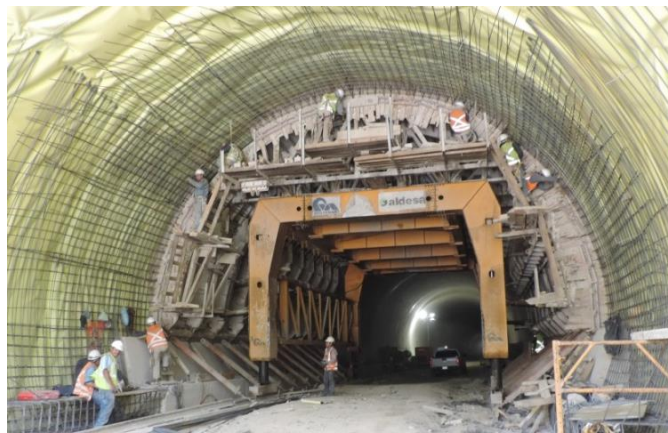
Figura 4.6. Construcción del revestimiento una vez estabilizada la excavación con los elementos de soporte y sostenimiento. Túnel Interlomas, México (Consultec).
