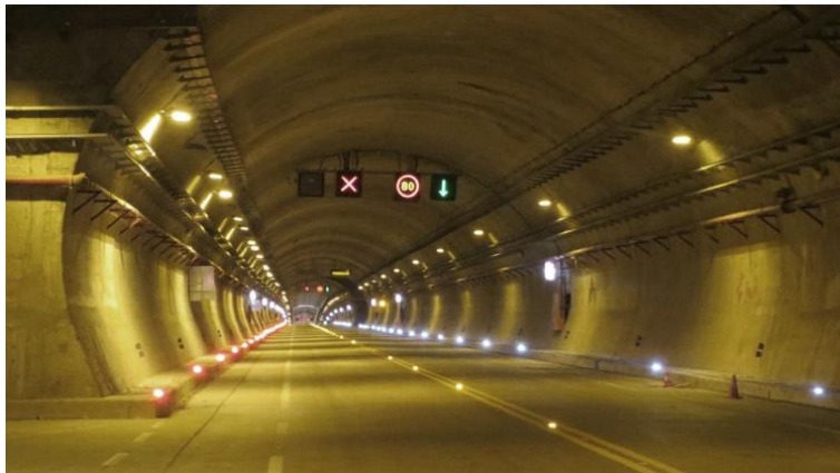
Figura 1.21. Revestimiento Túnel El Sinaloense, Ref. [19].
