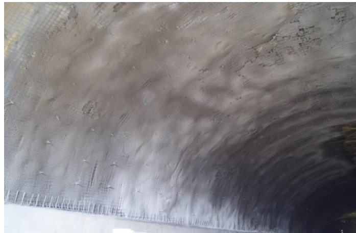
Figura 7.8. Revestimiento de concreto lanzado en los túneles Chimalpa.
