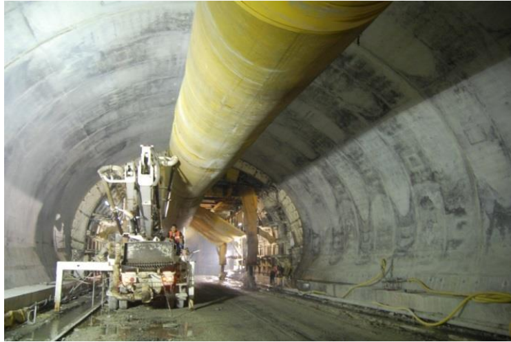
Figura 7.19. Acabado final del revestimiento.
