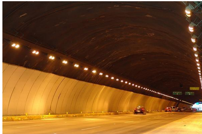
Figura 6.2. Concreto lanzado y revestimiento en hastiales con paneles. Túnel Loma Larga, Monterrey Nuevo León, México, Ref. [28].
