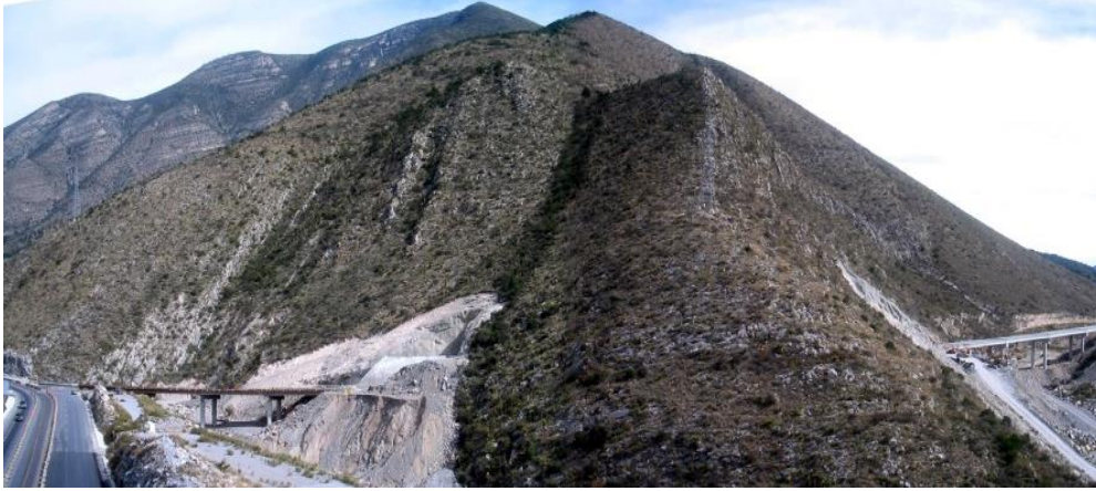
Figura 1.18. Túnel los Chorros, Carretera a Monterrey, México. (Cortesía: M.I. J. Francisco Suárez Fino).
