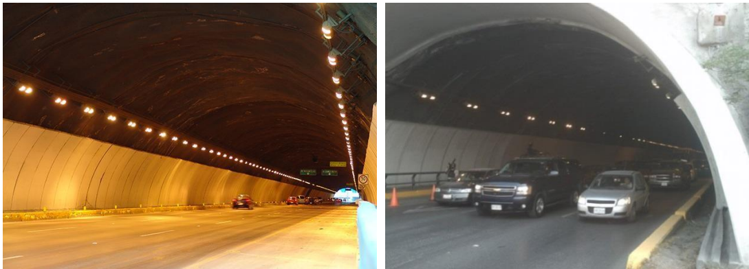
Figura 1.27. Túnel de Loma Larga, Monterrey Nuevo León, México. Ref. [23].
