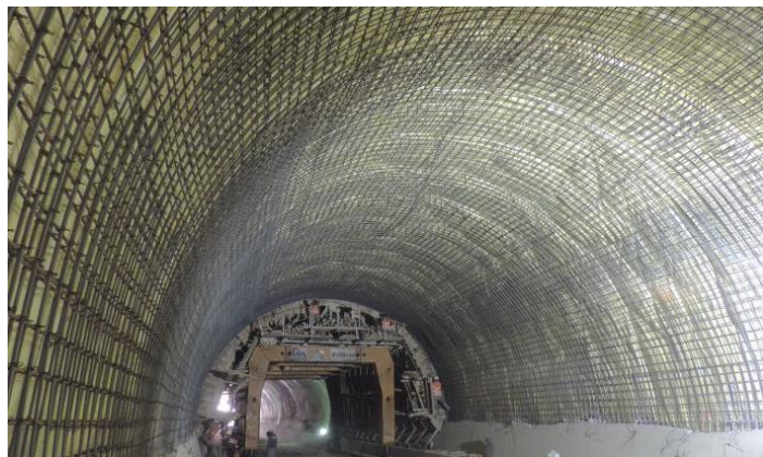
Figura 2.15. Acero de refuerzo colocado en clave y hastiales. Túnel Interlomas, México.
