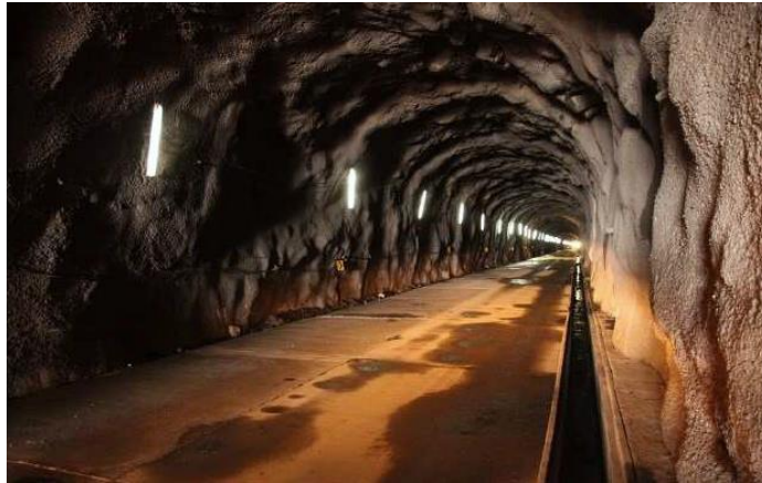
Figura 4.7. Túnel Kahuish con una Longitud de 1800 m, región de Áncash, Perú.
