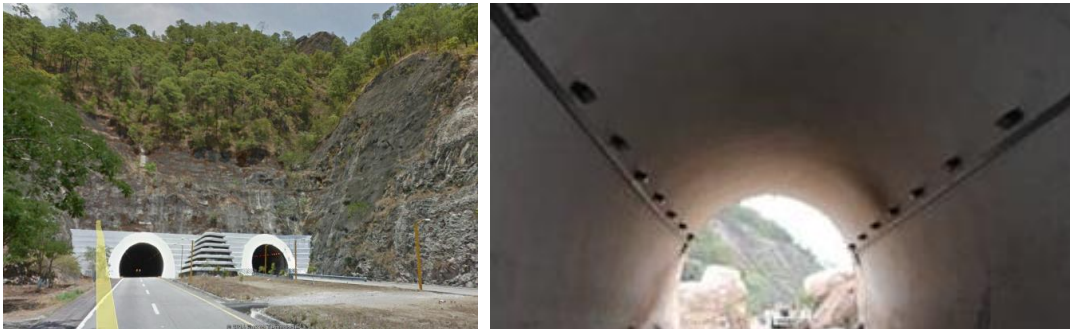
Figura 1.14. Portal e interior del túnel Agua de Obispo. Ref. [14].
