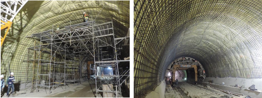
Figura 5.1. Colocación de acero, Túnel Interlomas, México. (Cortesía Consultec).
