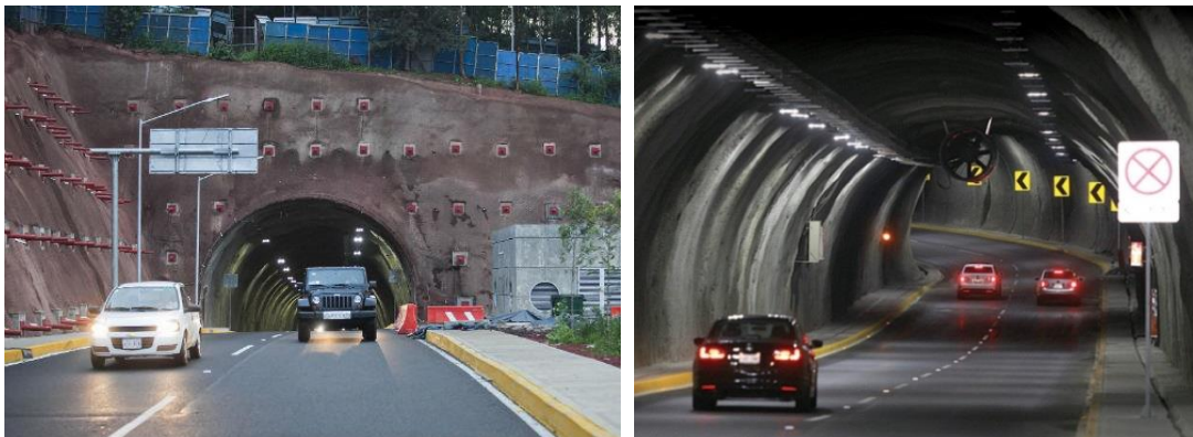
Figura 1.28. Supervía Poniente. Ref. [24].
