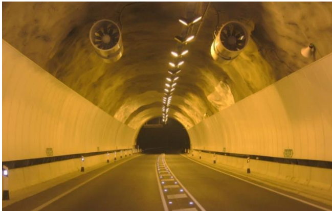
Figura 2.19. Revestimiento con paneles prefabricados. Túnel de Oliana-Coll de Nargo, Lérida España. (Cortesía M.I. J. Francisco Suárez Fino).
