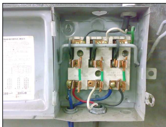
Figura 2.8A. Fusibles puenteados.
