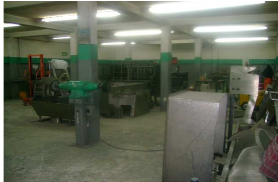
Figura 2.33. Vista general primer piso.
