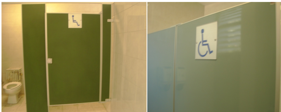
Figura IV.58. Baños reservados para personas con discapacidad.
