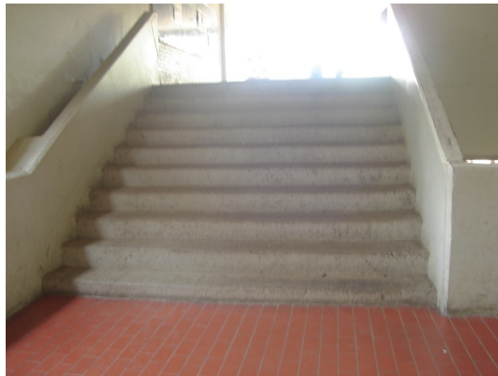
Figura IV.18. Escaleras Ala Poniente
