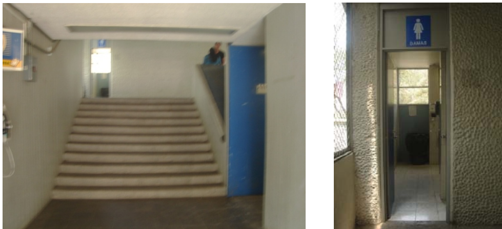
Figura IV.59. Acceso a sanitario ala poniente.
