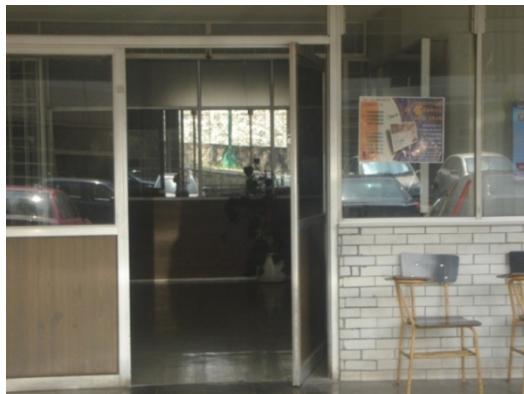
Figura IV.70. Puerta de entrada para las oficinas de docentes Anexo de Ingeniería.
