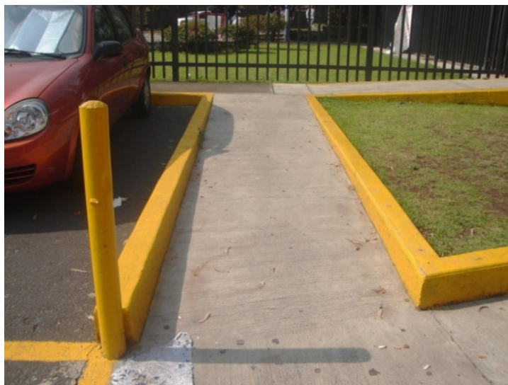
Figura IV.10. Rampa 1 del Estacionamiento para alumnos del Anexo de Ingeniería
