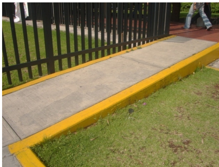
Figura IV.11. Rampa 2 del Estacionamiento para alumnos del Anexo de Ingeniería
