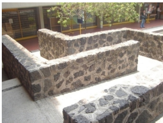
Figura IV.13. Rampa afuera de la Biblioteca del Anexo de Ingeniería
