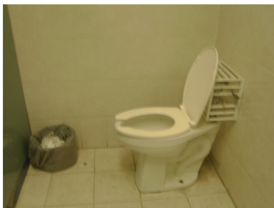
Figura IV.64. Inodoro del ala poniente, el cual no tiene barras de apoyo para personas con discapacidad.
