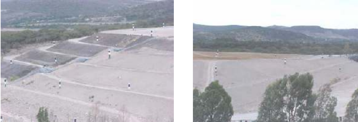
Figura 4.6 Relleno sanitario del municipio de Querétaro
