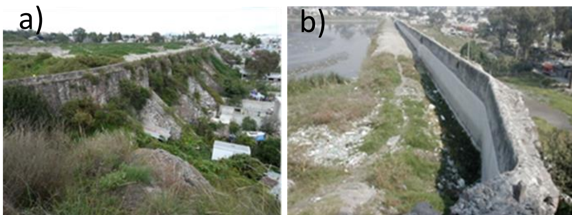
Figura 1.6. Presa Angulo (Cuautitlán) a) Nivel de agua al borde de la corona (Jaime, 2015), b) Nivel de azolvamiento (Jaime, 2015)
