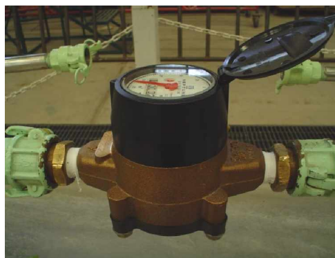
Ilustración A.4 Medidor tipo velocidad
