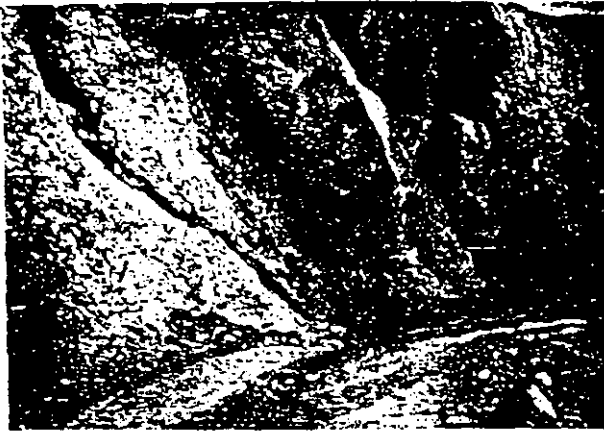
Falla rotacional de base. Obsérvese la salida de la superficie de falla al pie del talud.
