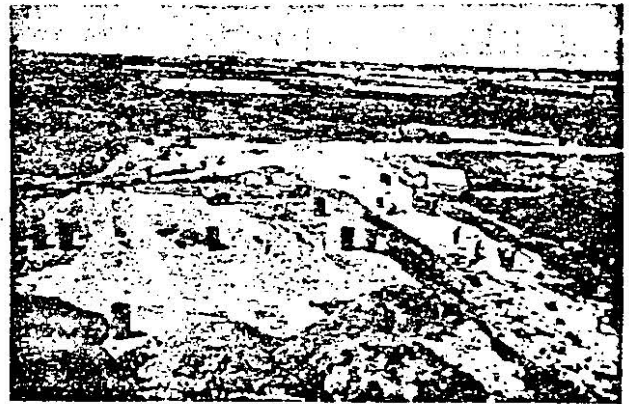
Vista de un terraplén de prueba instrumentado.
