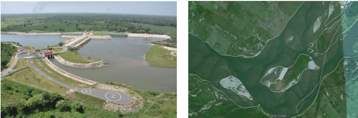
Figura 1.1 Lado izquierdo: Arreglo actual donde se pueden apreciar las dos estructuras junto con la escotadura cerrada. Lado derecho: Vista aérea de los ríos Mezcalapa, Carrizal y Samaria donde se puede apreciar la bifurcación
