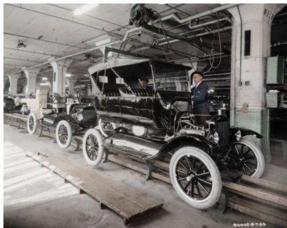
Figura 1 Ford Modelo T saliendo de la línea de ensamble móvil. (Ford Media, 2015)
