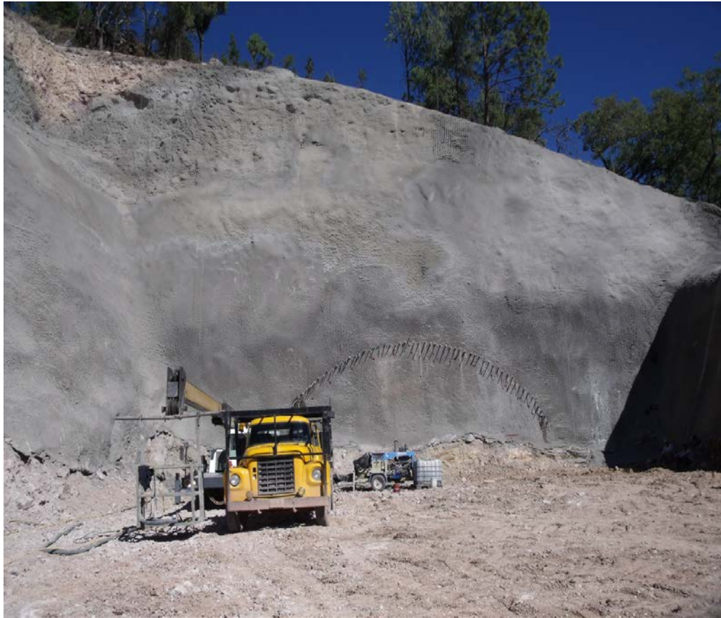
Fig. 2.3.1 Construcción de un portal, en donde se aprecia el talud frontal y el trazo de la sección superior del túnel.
