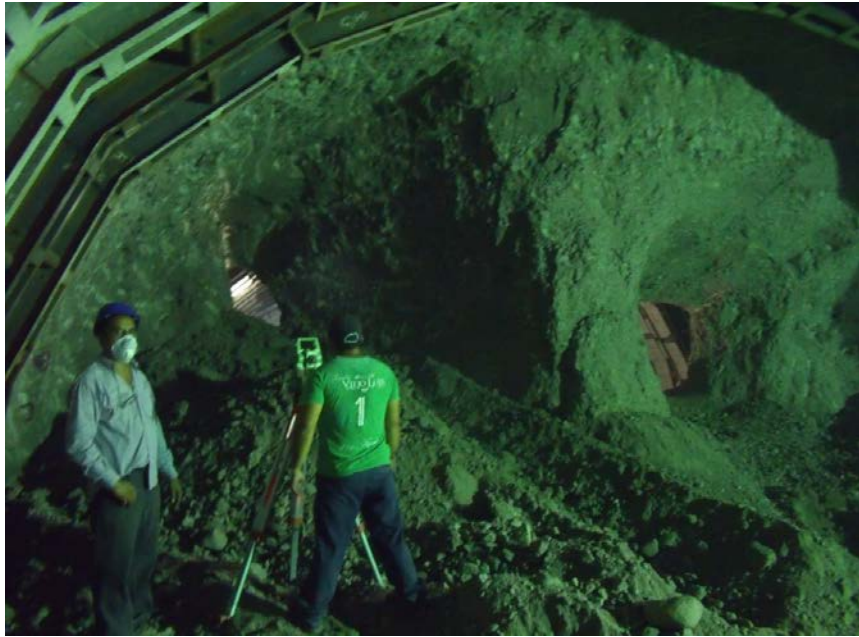
Fig. 4.1.5 brigada de topografía, sacando el avance de excavación en el frente
