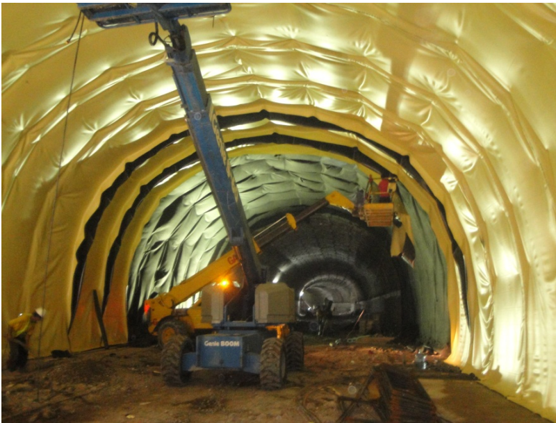
Fig. 5.1.1 impermeabilización de las paredes de túnel, al fondo se observa la colocación del geotextil de color negro, y de color amarillo la geomembrana
