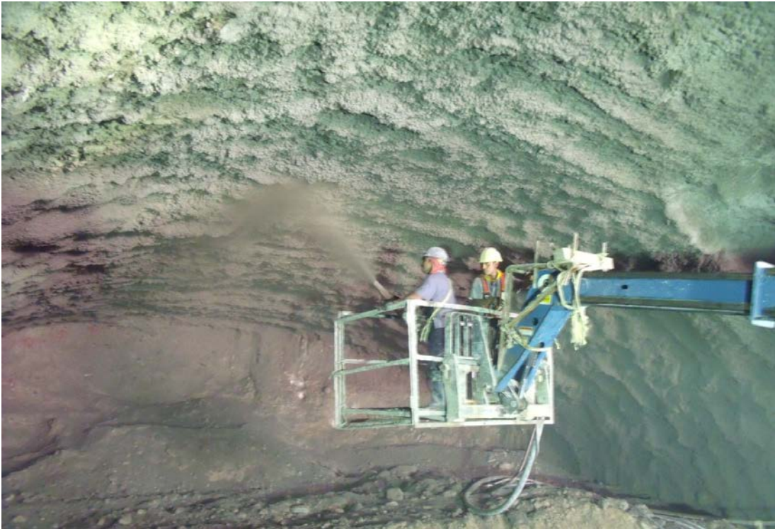
Fig. 2.3.4 excavación en roca, protegiendo las paredes mediante lanzado de concreto
