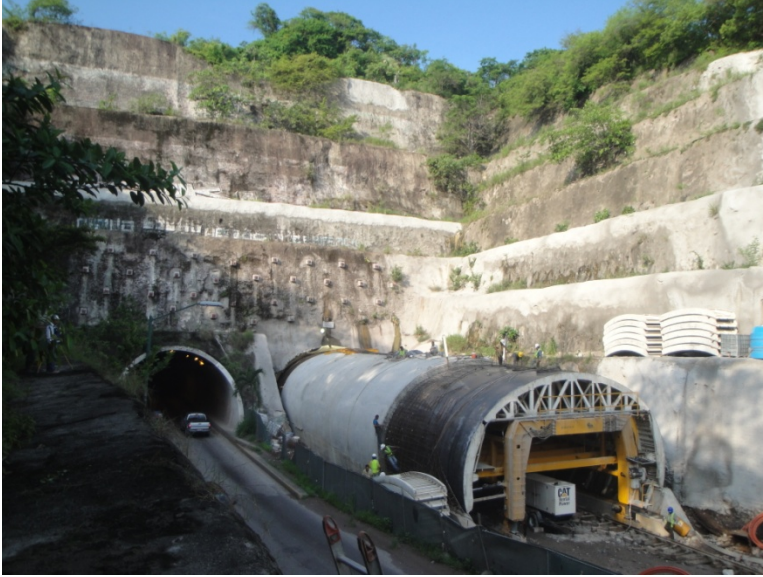
Fig. 5.1.2 Cimbra deslizante, en posición de ajuste en túnel falso
