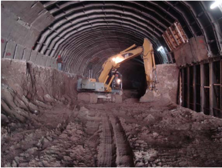
Fig. 4.3.2 excavación del banqueo central y lateral para colocar el complemento del marco
