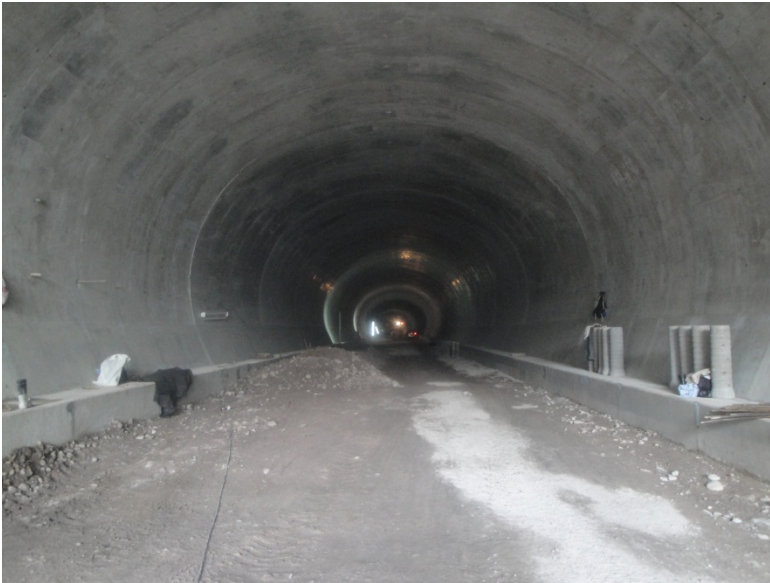
Fig. 5.1.3 revestimiento definitivo de túnel
