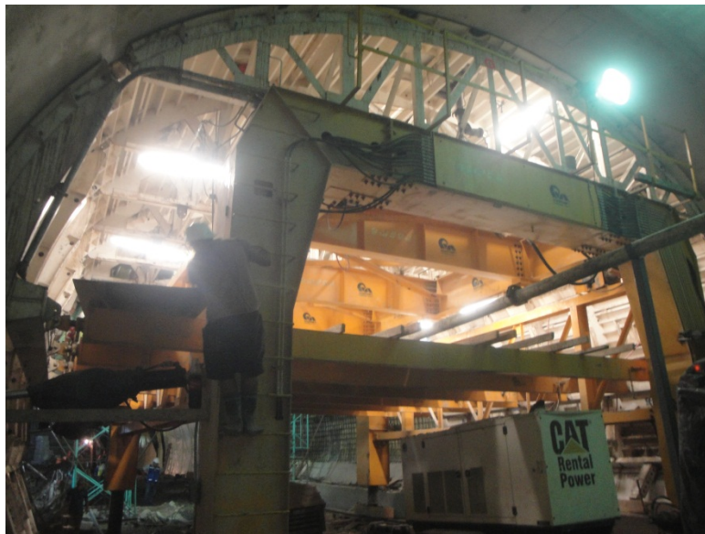
Fig. 5.2.1 Cimbra deslizante utilizada para el revestimiento definitivo
