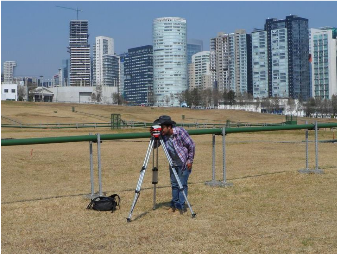
Figura 4.4. Levantamiento topográfico con nivel y estadal
