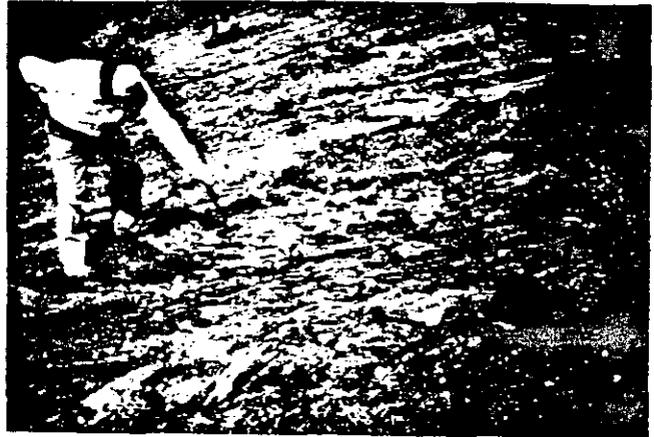
Fig. 5 Contracción del revestimiento asfáltico en Zumpango, Méx.
