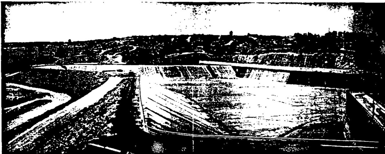
Fig. 12 Revestimiento de CSPE del vaso regulador en Agua Prieta, Jal., 1993.
