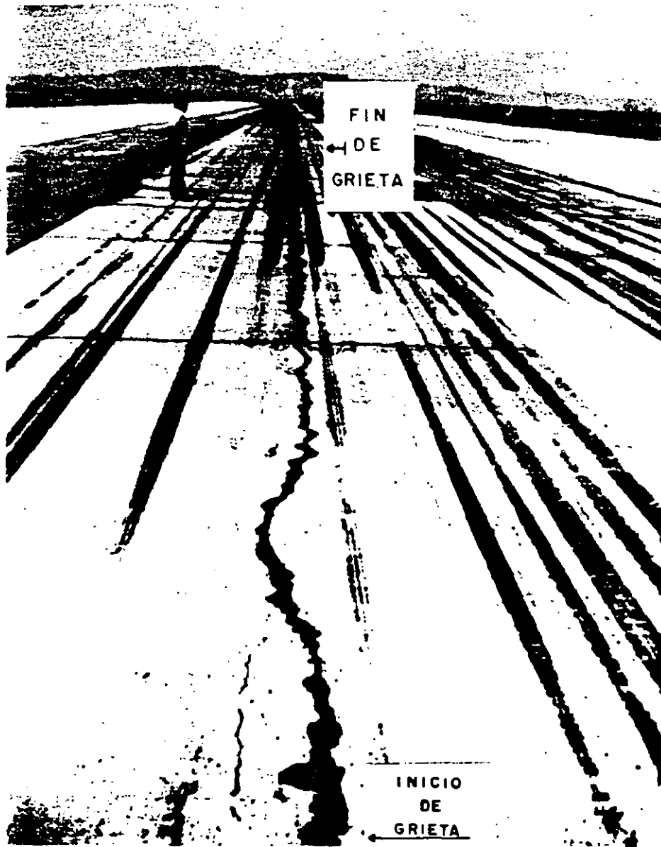
Fig. 14-18 Grietas longitudinales en las losas contiguas al eje de la pista y sólo en una zona de la misma. Las grietas ya han sido selladas. El alabeo, las cargas y la poca resistencia del concreto en la zona, son las probables causas de la falla
