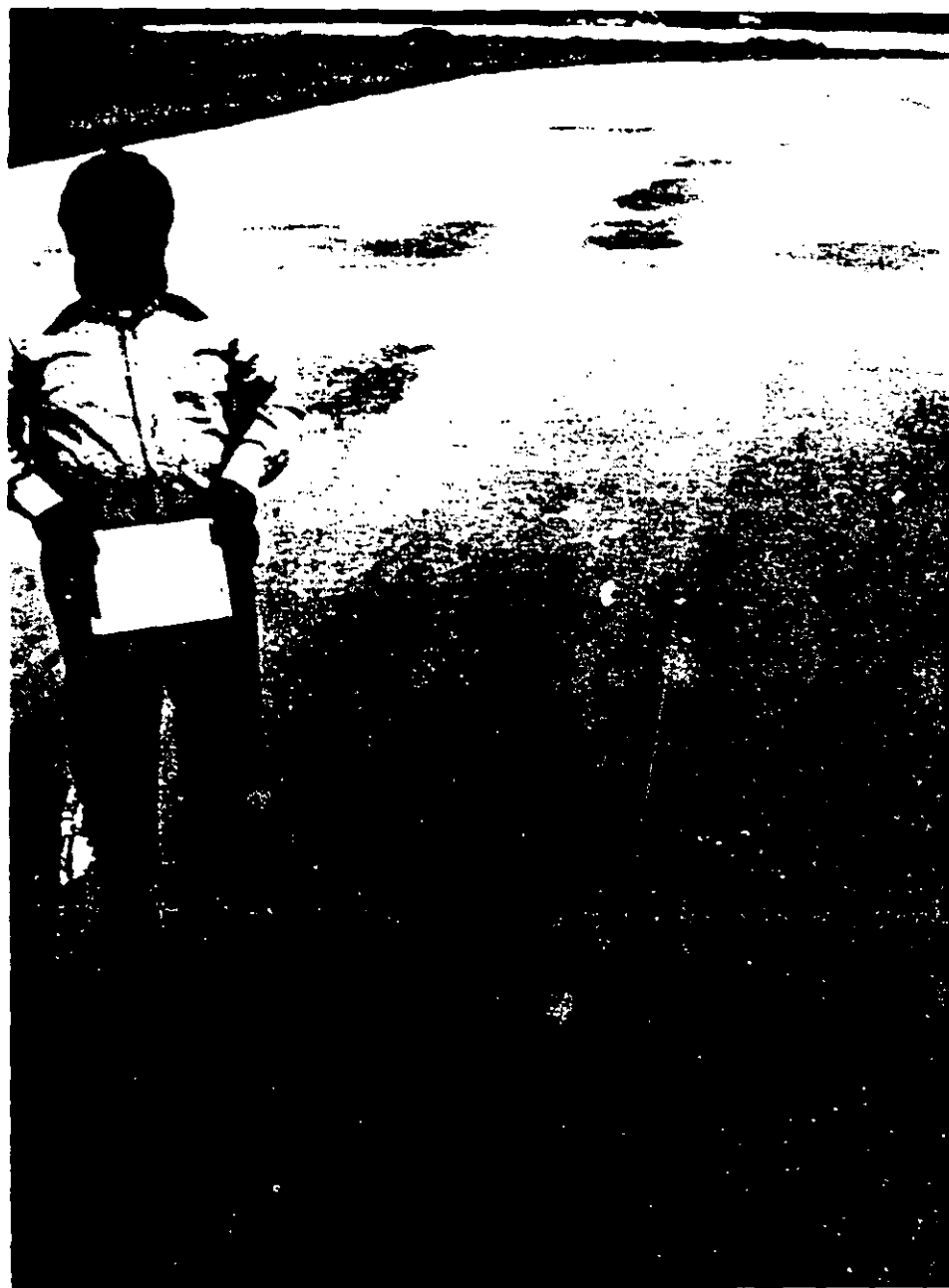
Fig.2.5-8 Sangrado o afloramiento de asfalto y formacion de pequeños charcos en una calle de rodaje
