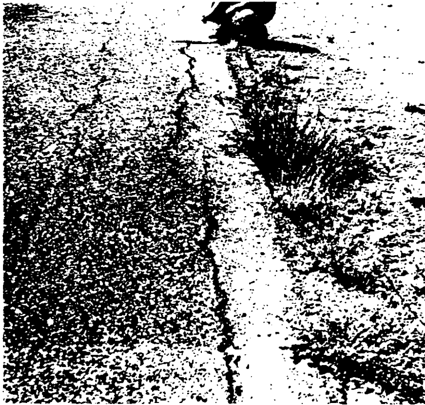
Fig. 2.5-26 Grietas longitudinales de orilla debidas probablemente a contracciones por secado de la subrasante
