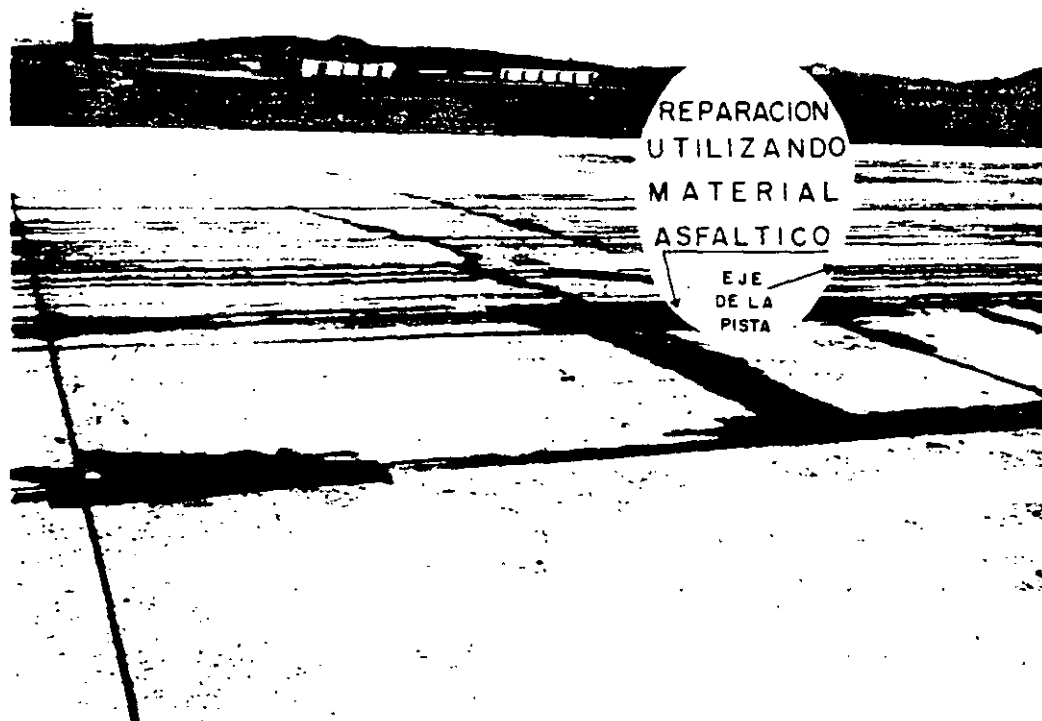
Fig. 1.4-26 Grietas longitudinales y transversales y algunos astillamientos en el tramo central de la pista, ya tratados con material asfáltico. La falta de apoyo de la cimentación, las cargas, efectos de impacto y los efectos de temperatura son las probables causas de la falla
