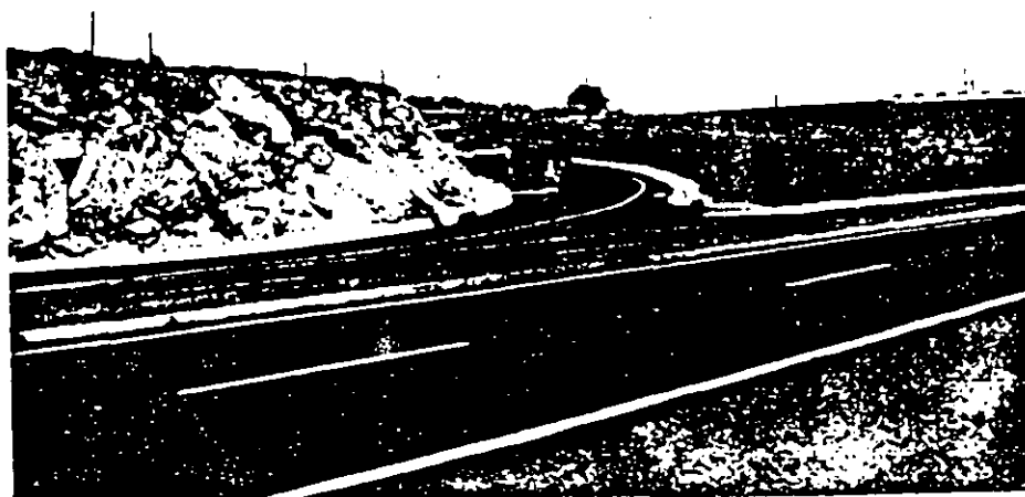
ASPECTO DE UNA CARRETERA EN SERVICIO, CUYA CARPETA SE REALIZO CON EMULSION.
