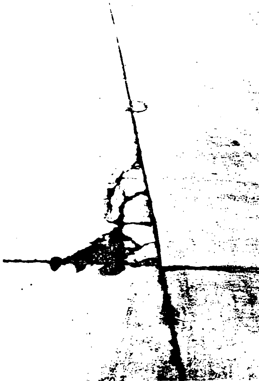
Fig. 1.4-35 Grieta en esquina y efectos de "bombeo"
