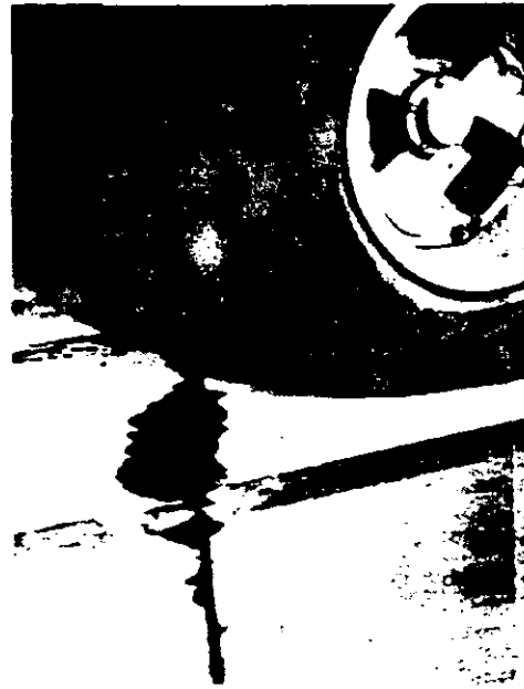
Fig. 1.4-44 Al paso de un "eje doble-doble tandem" es "bombeado" el agua con finos hacia el exterior.
