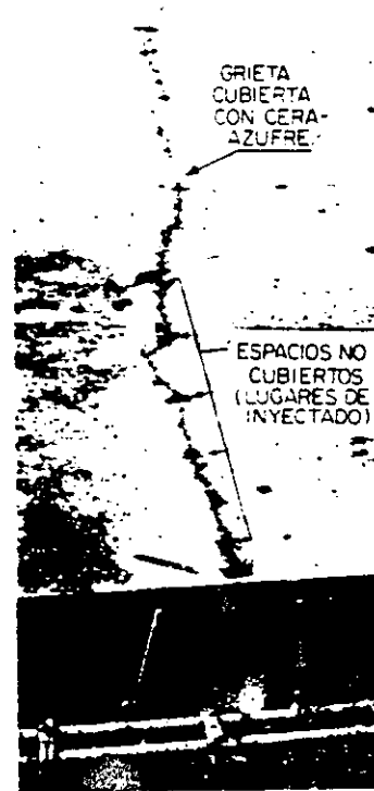
Fig. 1.4-29 Preparación de la grieta para su sellado
