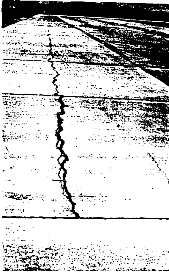
Fig. 1.4-19 Grietas longitudinales, ya selladas, localizadas en el centro de las losas de orilla y centro de una calle de rodaje. Ligeros movimientos en la cimentación y alabeos son las probables causas de la falla
