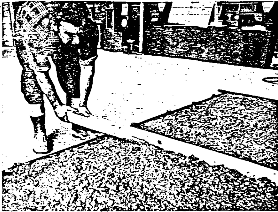
Figura 12.- Nivelado por medio de una regla de madera y las orillas de la cimbra.
