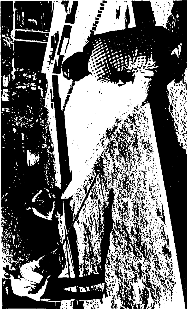
Figura 12. Enrasado entre las guarniciones.
