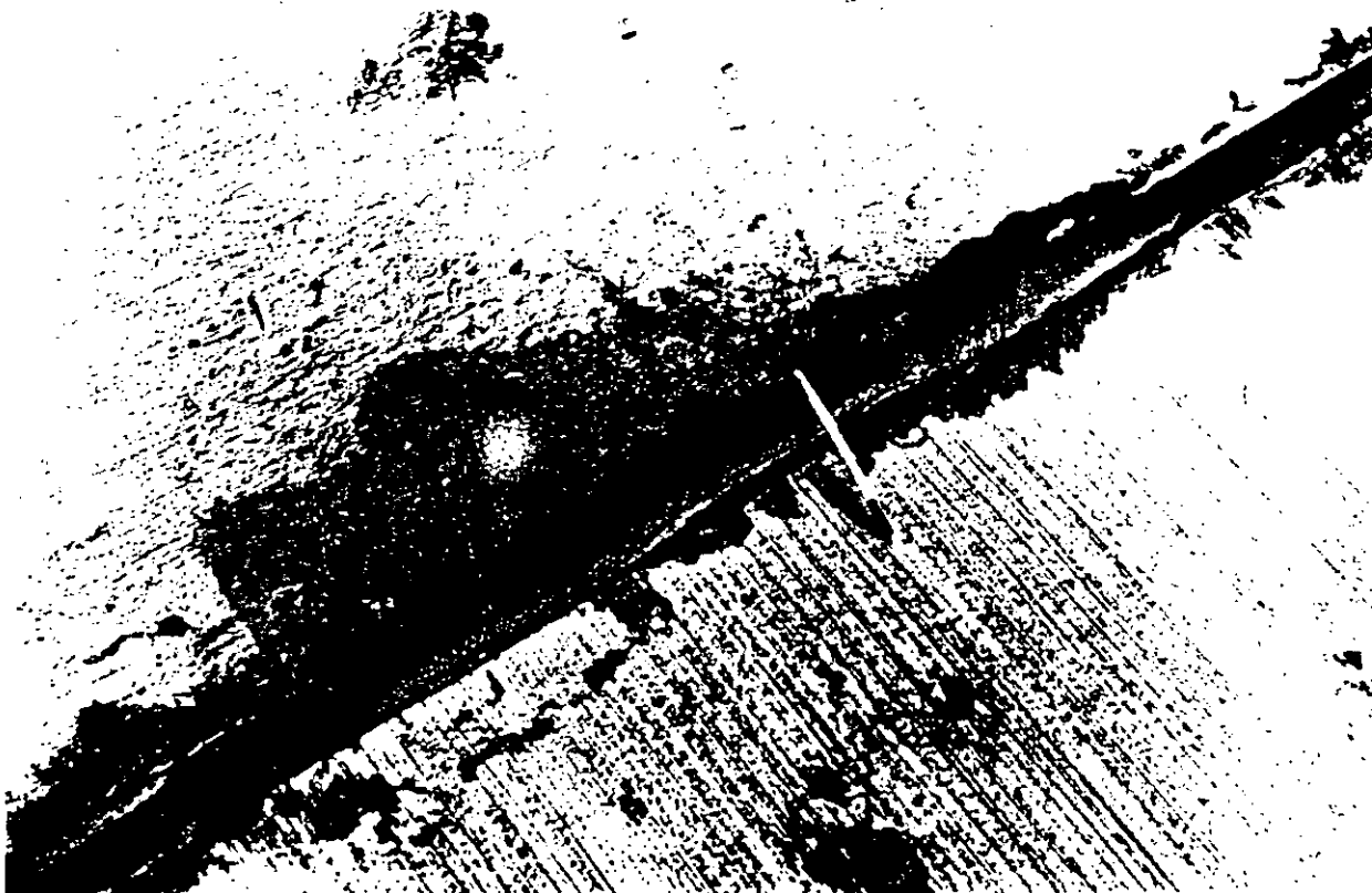
Fig. 1.4-56 Material de sello que ha perdido sus características para trabajar adecuadamente. Una parte se ha despegado de las losas y el polvo y la tierra comienzan a invadir la junta, lo que ya ha dejado de ser impermeable
