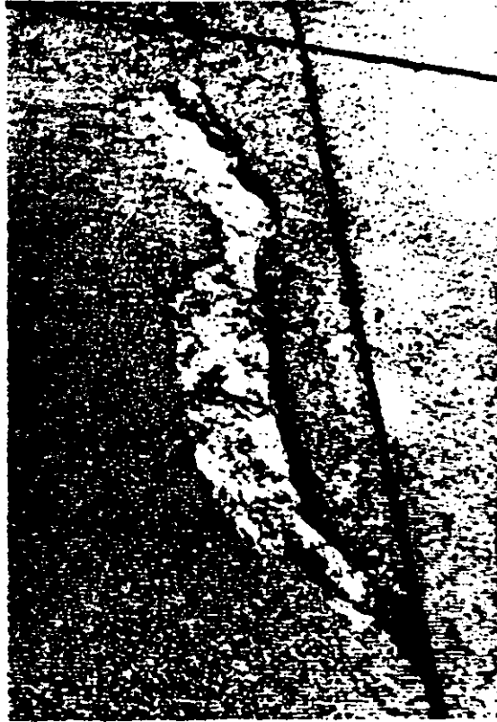
Fig. 1.4-33 Grietas en esquina combinados con desconchamiento. Probable falla estructural e impedimento de movimiento
