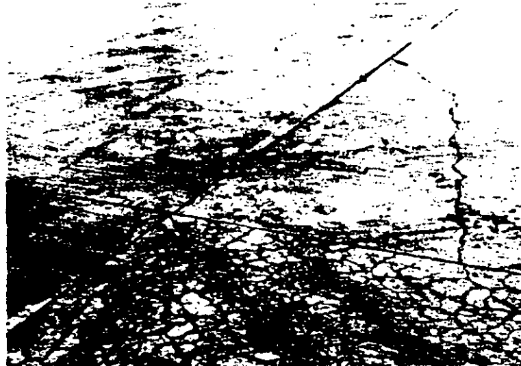
Fig. 1.4-41 Grieta en diagonal y grietas en esquina. Fallo estructural debido probablemente a la falta de apoyo de las losas, subdrenaje defectuoso y a las cargas
