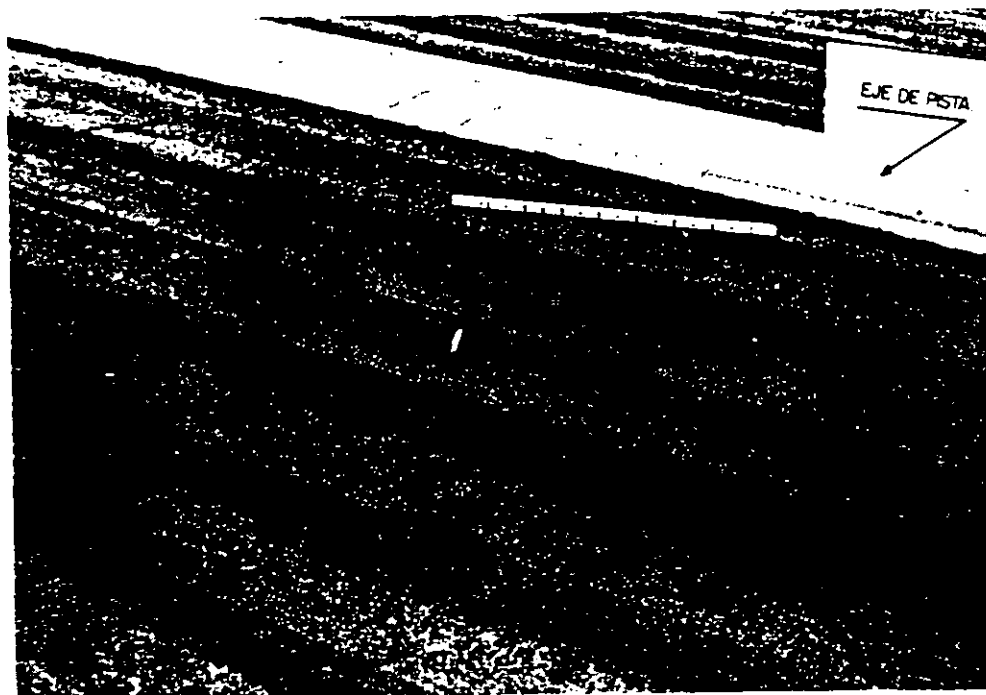
Fig. 2.5-15 Corrimientos circulares
