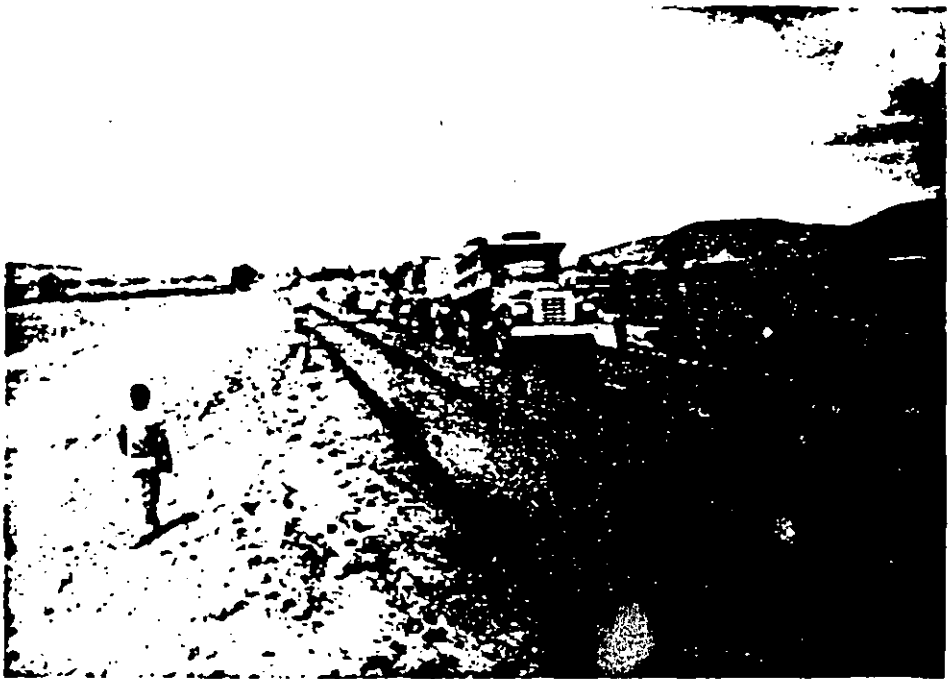
DISTINTOS ASPECTOS DEL TENDIDO DE CARPETA EN FRIO FABRICADA CON EMULSION, EN EL ESTADO DE MICHOACAN.
