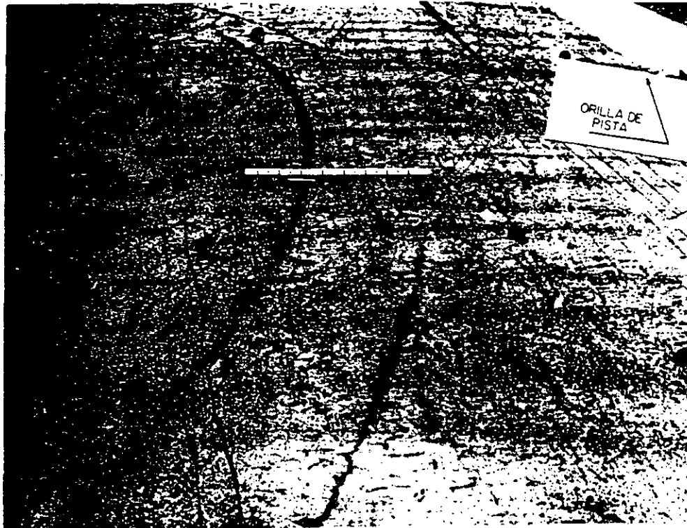
Fig. 2.5-14 Corrimientos circulares o radiales
