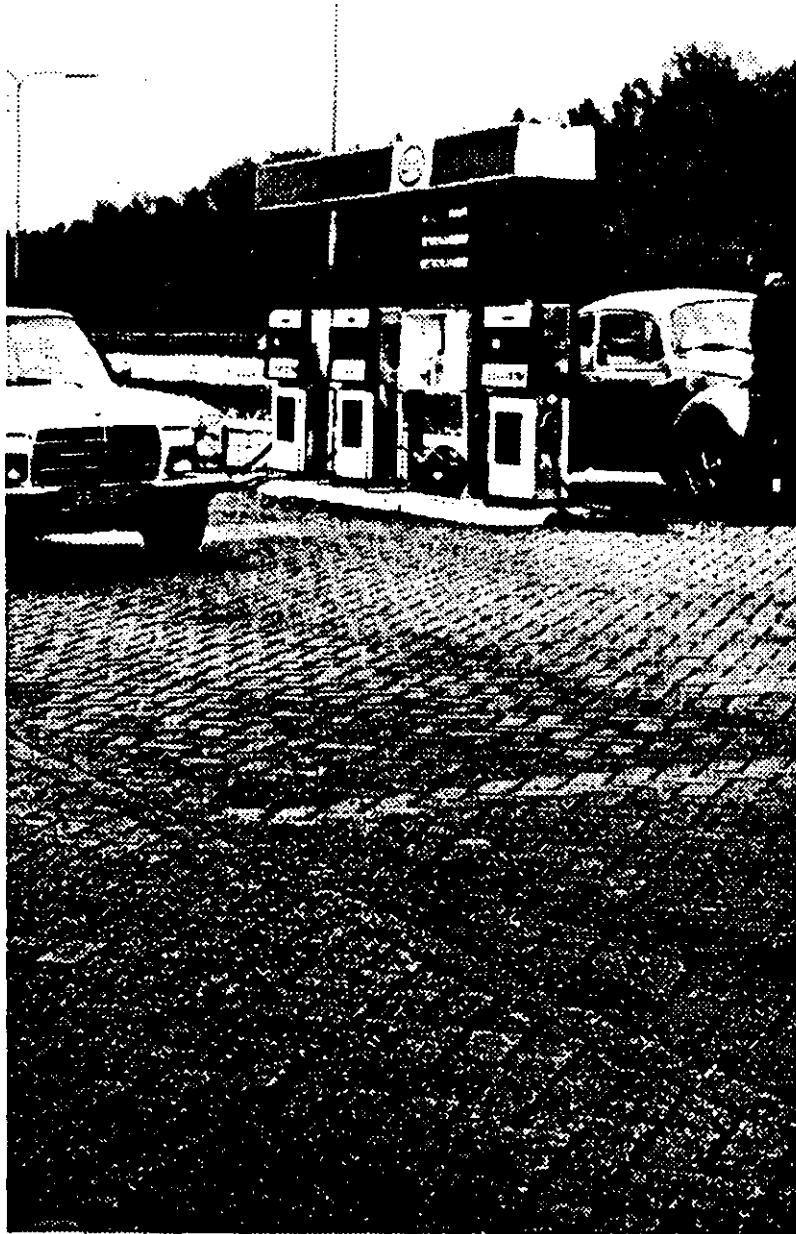
Figura 5. Area de servicio de una gasolinera.
