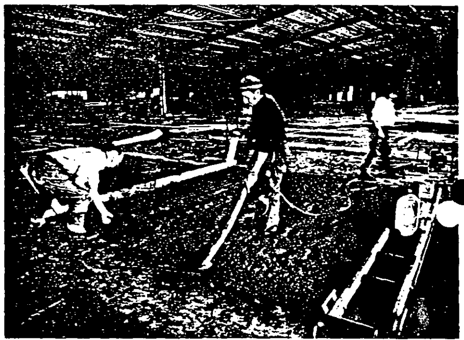
Figura 7.- Vista general de operaciones, que muestra el proceso de nivelación por medio de doble vibración, el vibrado de la orilla de la losa a base de un vibrador de inmersión y, a la derecha, el apisonamiento y marcado al nivel de la malla de ref. antes de su colocación.
