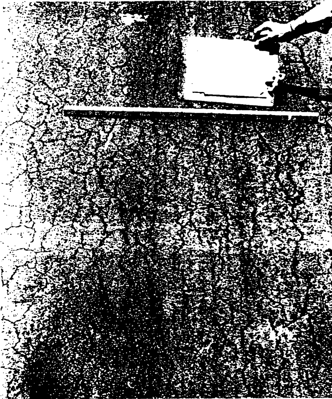
Fig. 2.5-40 Grietas en forma de piel de cocodrilo con espacios regulares y asentamientos de relativa gran amplitud, lo cual es indicativo de que el problema proviene de las capas más alejadas de la superficie. Los espacios estrechos indican que también hay problema en las capas superiores
