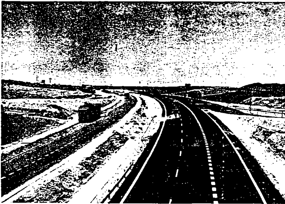
Fig. 15 Autovía en operación
