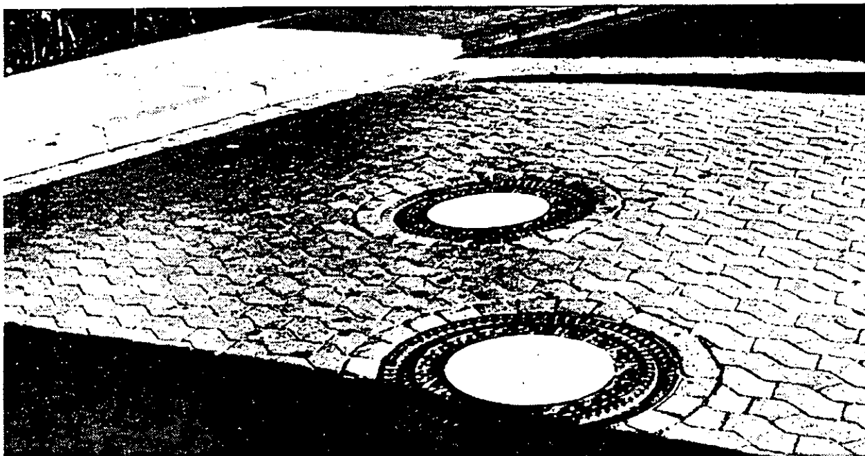
Figura 10. Cubiertas de inspección.
