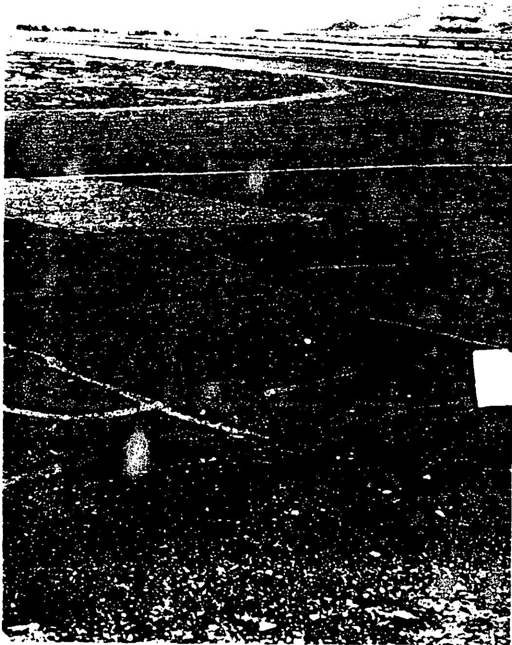
Fig. 2.5 - 33 Grietas transversales y un bache reparado. Es deseable que el acabado del parche sea igual que el del pavimento que lo rodea, y es indispensable que los niveles de sus superficies coincidan
