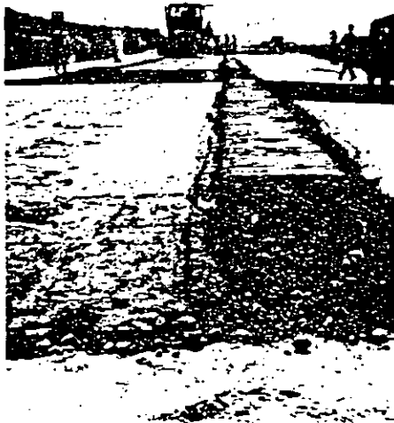
Fig. 9 Bordillo de contención y amarre
