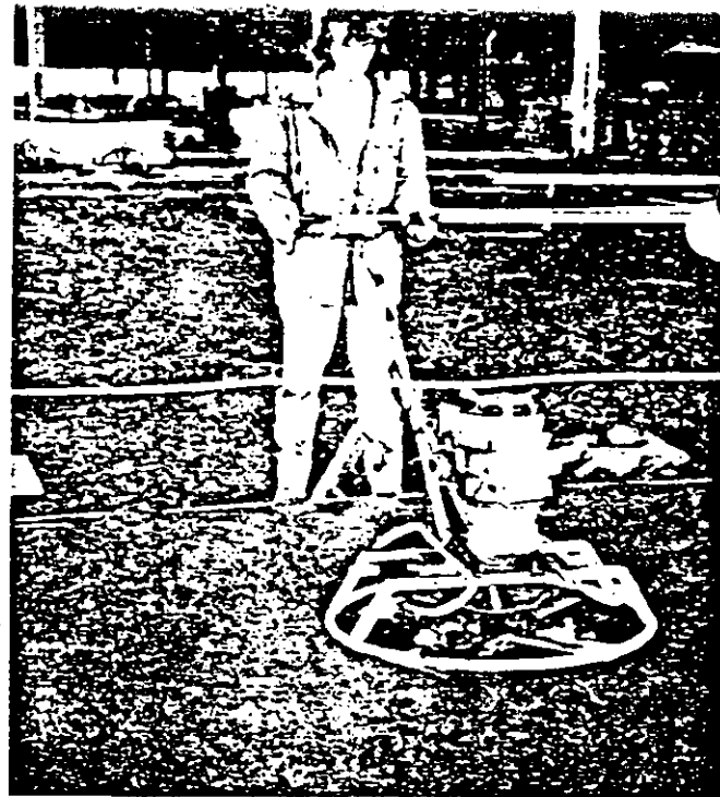
Figura 15.- Aplanado mecánico.
