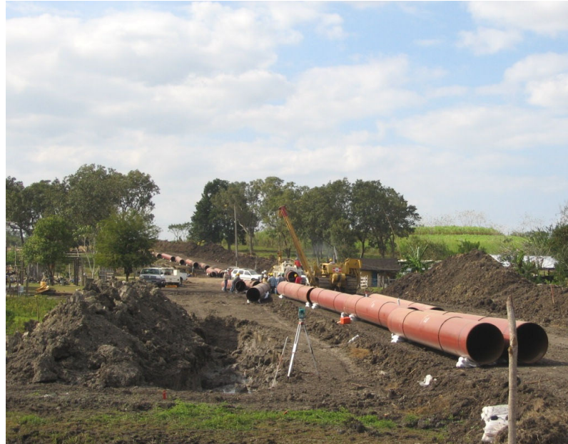
Figura 5.10 Arreglo de Tuberías y Construcción para el Área de Trampa de Diablos.
