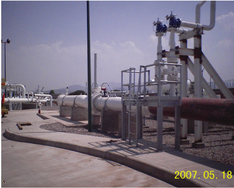
Figura 5.10 Arreglo de Tuberías y Construcción para el Área de Trampa de Diablos.
