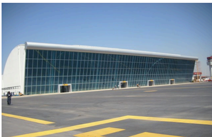
Fotografía 12. Ampliación del edificio de pasajeros y plataforma del Aeropuerto Internacional de Puebla.
