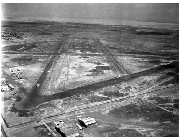
Fotografía 6. A la derecha de la fotografía se observa la construcción de la pista 05R/23L en el ya internacional Puerto Aéreo Central de la Ciudad de México, 1949. Ref. 2.
