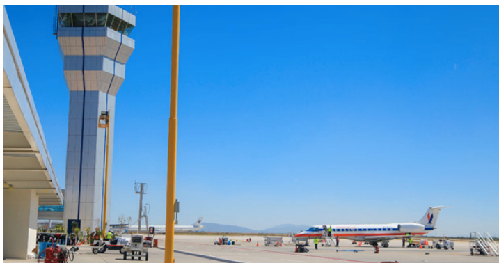
Fotografía 15. Plataforma y torre de control del Aeropuerto Internacional de Querétaro.
