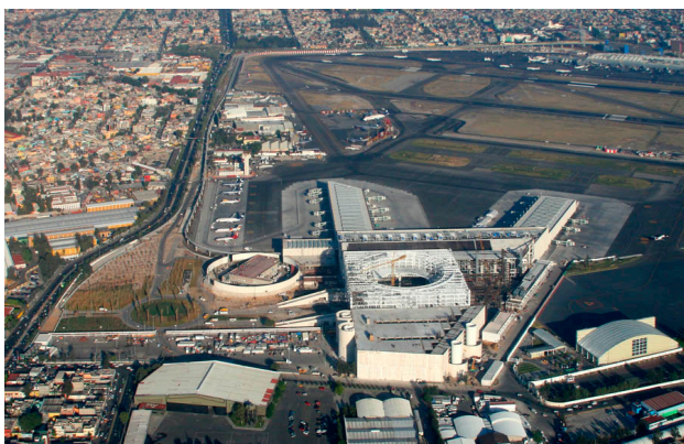
Fotografía 8. Construcción de la Terminal 2 del AICM en 2006. Ref. 5.
