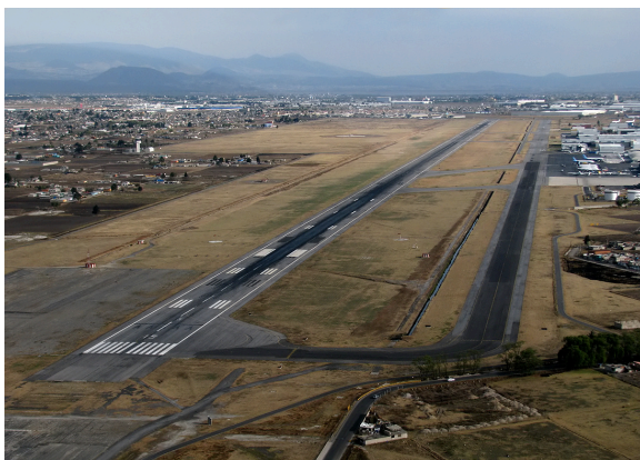
Fotografía 11. Pista 15/33 del Aeropuerto Internacional de Toluca.
