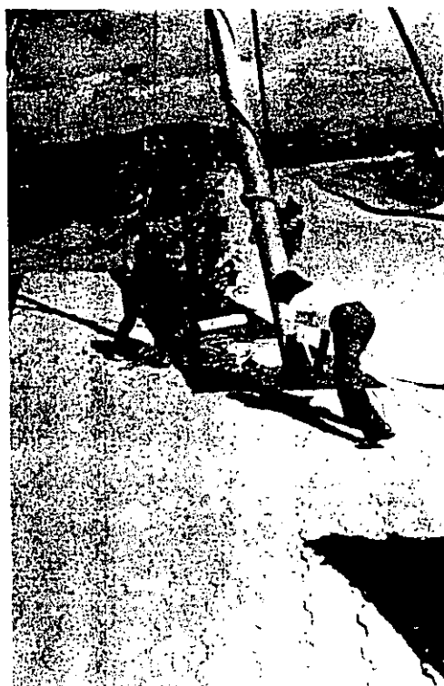
Diferentes aspectos del parado de un poste por medio de garrucha y tripie.
