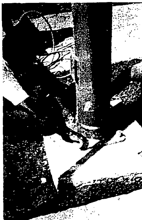
Diferentes aspectos del parado de un poste por medio de garrucha y tripie.
