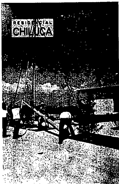
Diferentes aspectos del parado de un poste por medio de garrucha y tripie.
