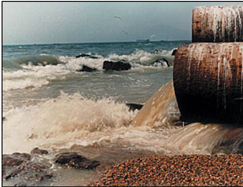
Figura 1. Descarga de aguas residuales al mar.
