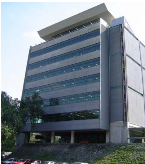
Imagen 21. Fachada doble de la Torre de Ingeniería. Vista exterior (izquierda). Vista interior del corredor (derecha)
