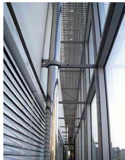
Imagen 16. Fachada de ventilación multi-nivel. Fuente Loncour (2004)
