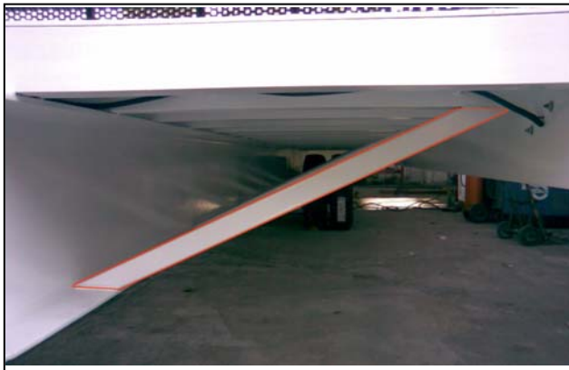
<<< Fig. 3.7 Detalle de refuerzo lateral
