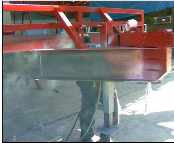
Fig. 4.36 Aplicación de primario en el remolque. >>>
