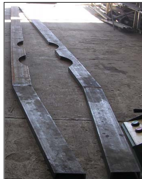
Fig. 4.27 Canales laterales >>> habilitadas para su armado.
