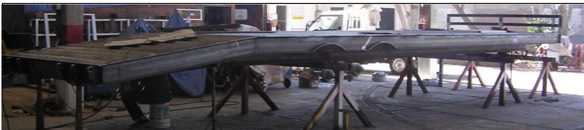
Fig. 4.33 Armado terminado de chasis y cama del remolque.
