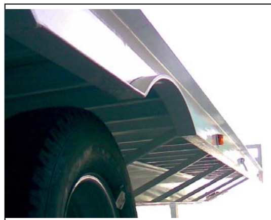
Fig. 3.8 Refuerzos laterales en uno de los costados. >>>
