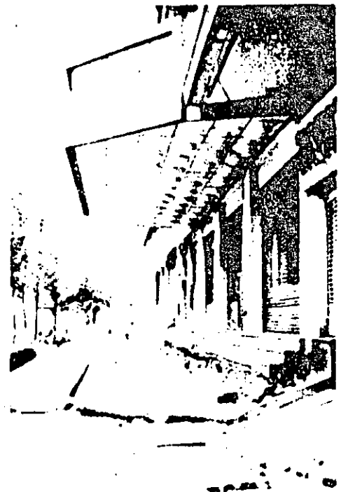
Fig. 14 Asentamiento del suelo alrededor de un edificio con pilotes de punta
