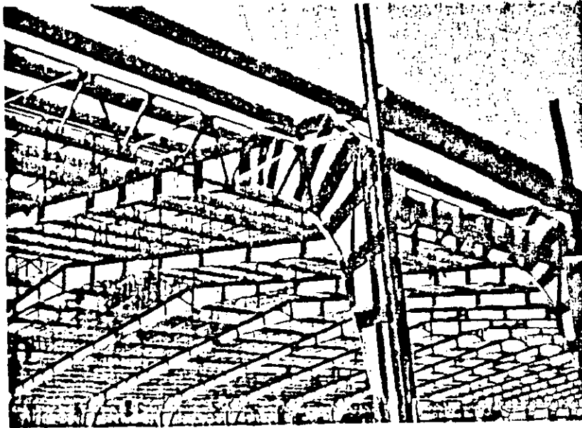
MARCO RIGIDO Y ARMADURAS.
