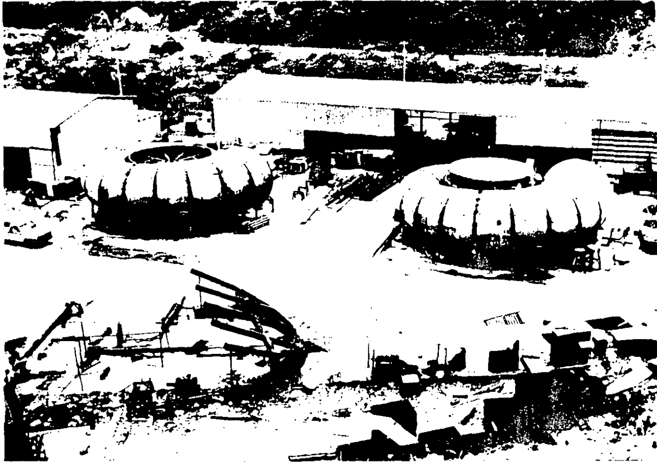
VISTA DEL PATIO DE MONTAJE (PRESENTACION DE LAS CÁRCAZAS)
