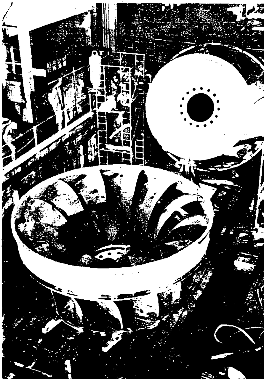
DETALLE DE FABRICACION DEL RODETE, SOLDANDO LOS ALABES A LA BRIDA
